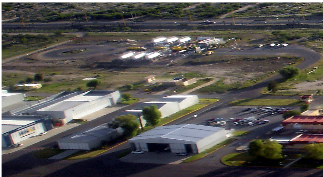
Figura 2.7 Almacenamiento y distribución de combustible.
