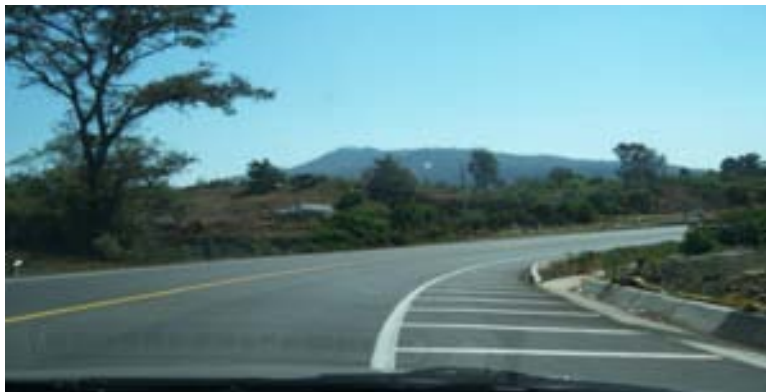
Fotografía 3.6.2 Ampliación actual de la curva
