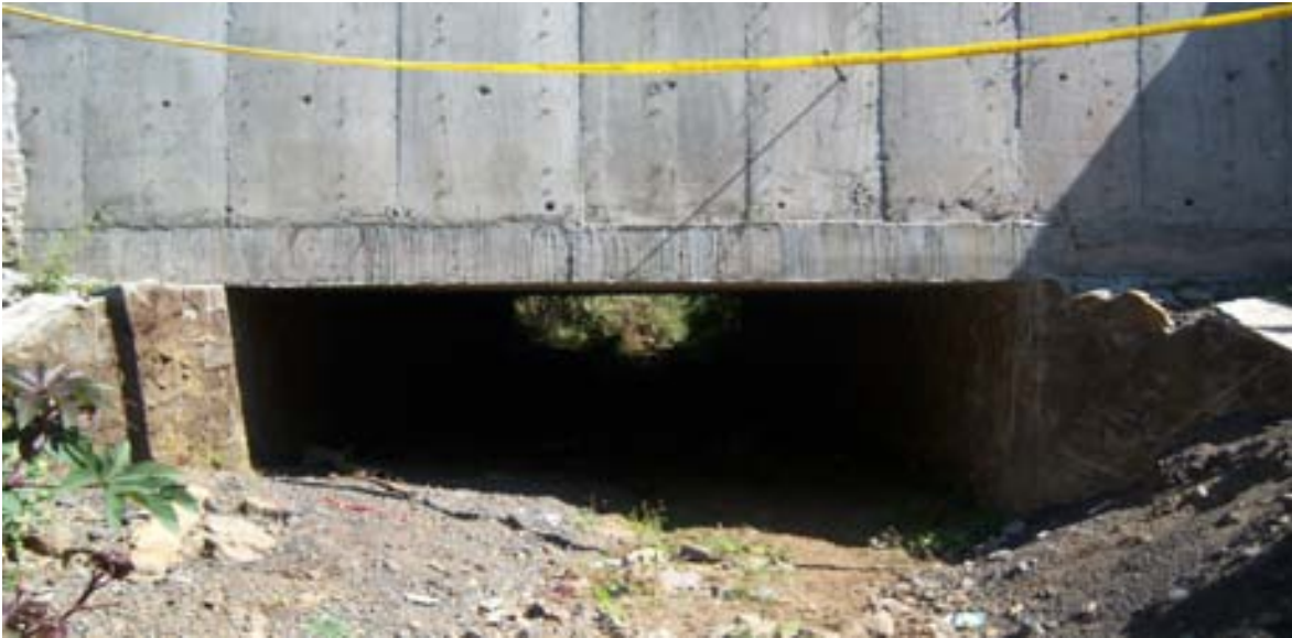
Fotografía 3.5.5 Estructura de puente
