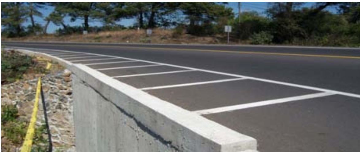
Fotografía 3.5.4 Ubicación del puente en el trayecto de la curva
