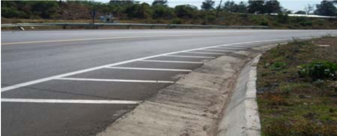
Fotografía 3.5.3 Ampliación de curva
