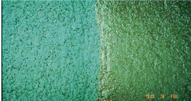
**En esta fotografía se muestran las texturas del mortero colocado con algunas horas de diferencia. Nótese la diferencia de color.**
