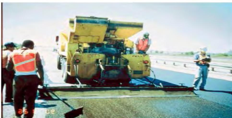
**Máquina colocando mortero asfáltico.**
