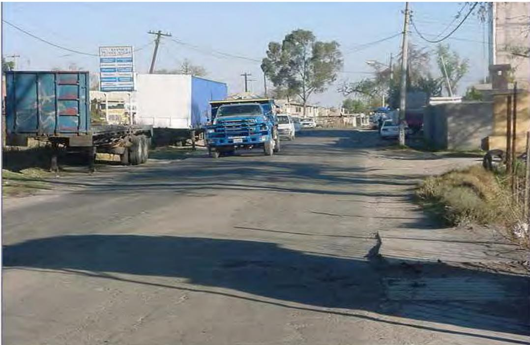
Del km. 24 + 360 al km. 28 + 220 aproximadamente, presenta zonas de baches, agrietamiento en forma de piel de cocodrilo, zonas de agrietamiento longitudinales y transversales.
