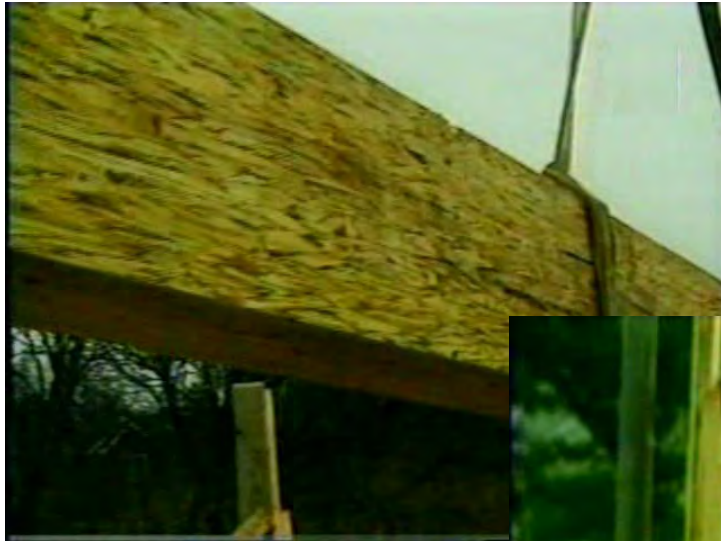
Vigas estructurales a base de Madera reciclada.
