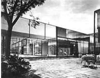
Edificio de Departamentos
