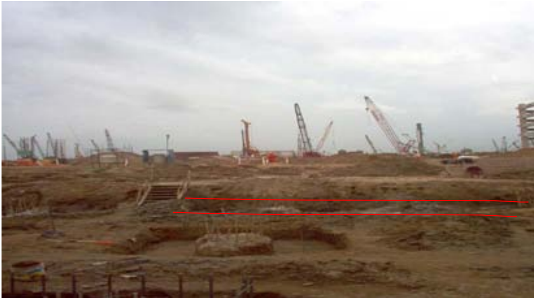
Fotografía 7.2.2. Se muestra el relleno que han colocado sobre el material con materia orgánica formado, el cual presenta intercalaciones de arena y arcilla. Refinería Lázaro Cárdenas.
