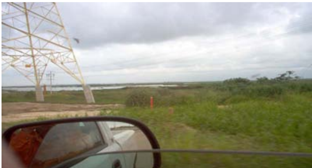
Fotografía 7.2.1. Se muestra la zona pantanosa y junto a ella una torre eléctrica a la cual le han colocado suelo de relleno en su base, este suelo es un material arenoso-arcilloso, muy inestable. Esta fotografía fue tomada en la “Refinería Lázaro Cárdenas”.
