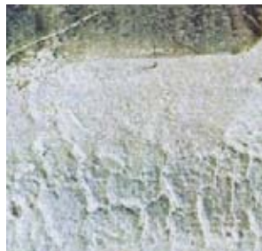
Figura 3.6 Grietas en el herramental [1].
