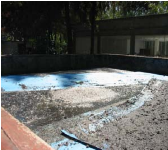
Figura 5-27. Comienzo de la formación de nata sobre uno de los puntos de alimentación del digestor
