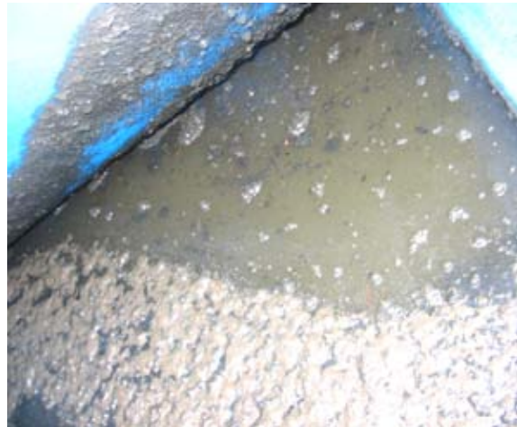
Figura 5-26. Apariencia del espejo de agua con nula formación de nata después de haber colocado las hojas de polipropileno
