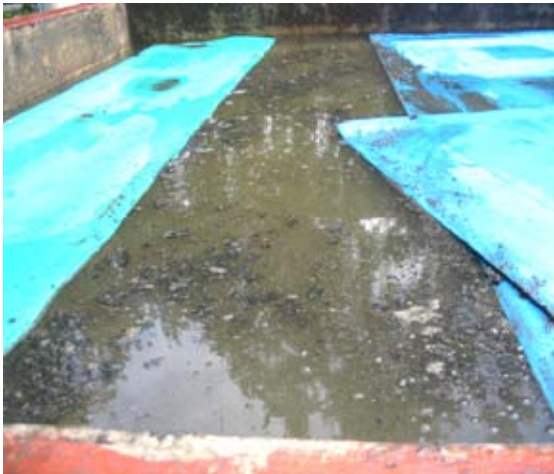
Figura 5-25. Apariencia del espejo de agua con nula formación de nata después de haber colocado las hojas de polipropileno
