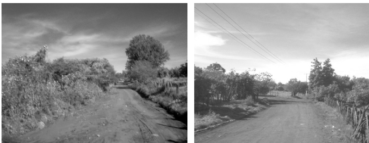
Fotos 3.9.- El camino actualmente cuenta con cunetas sobre terreno natural que permiten el desalojo del agua.
