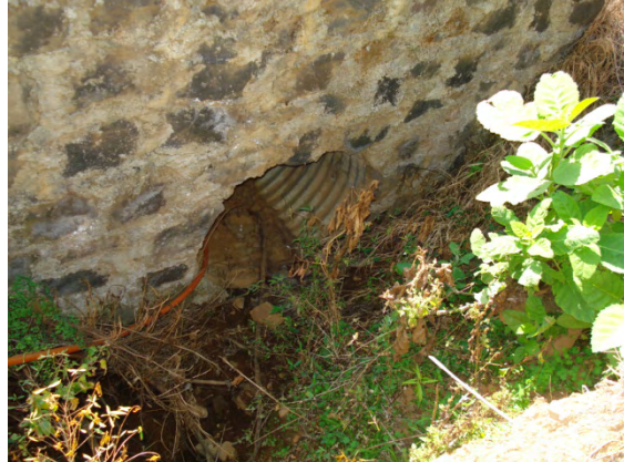
Alcantarilla en km 1+720
