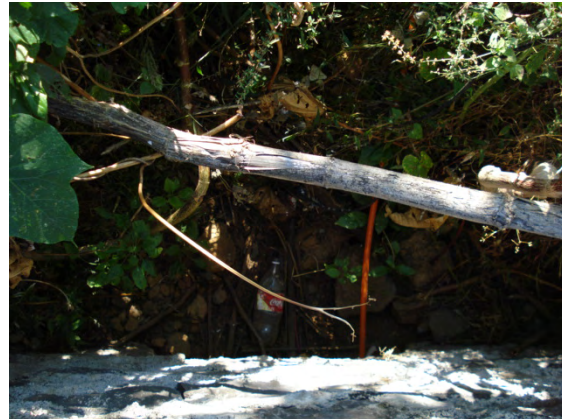
Alcantarilla en km 0+280
