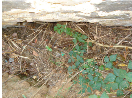
Vista aguas arriba de la alcantarilla.
