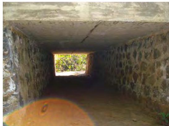
Vista interior de la alcantarilla
