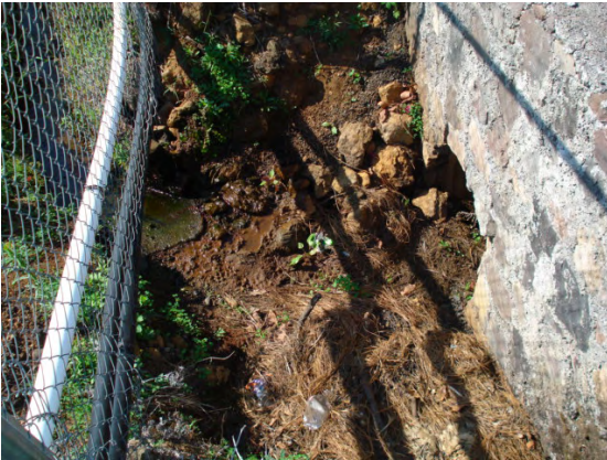
Alcantarilla en km 1+080
