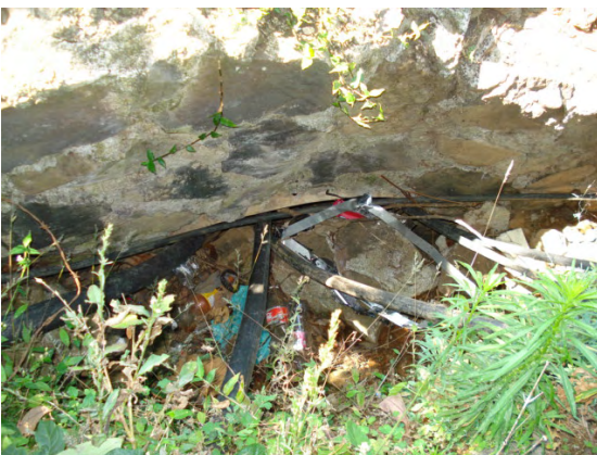
Alcantarilla en km 0+180
