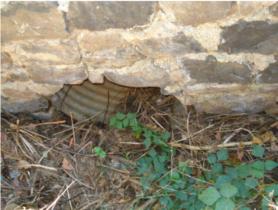
Vista aguas abajo de la alcantarilla.
