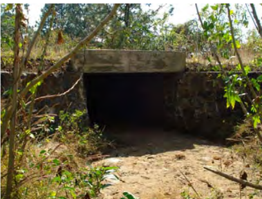
Vista aguas arriba de la alcantarilla
