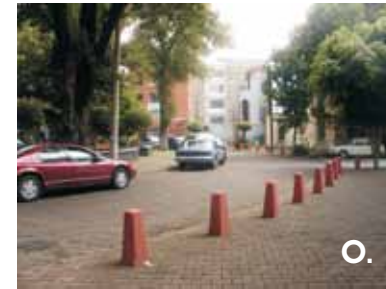
El mismo adoquín está colocado en la calle vehicular y en las banquetas, solo se diferencia por un ligero cambio de nivel y unos guardacantones que protegen al peatón.
