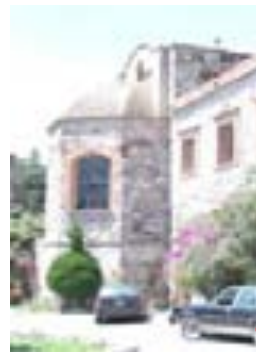
Fig. 30 Es la fachada poniente de la capilla
