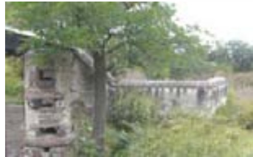
Fig. 44 Restos del puente por el cual podemos acceder al jagüey.
