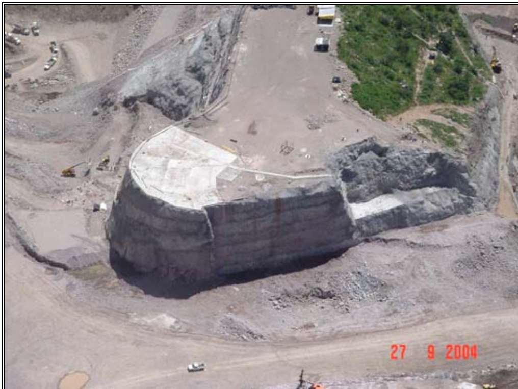
Fotografía IV.1. Vista de la excavación del muro alabeado y la zona de estructuras de control.
