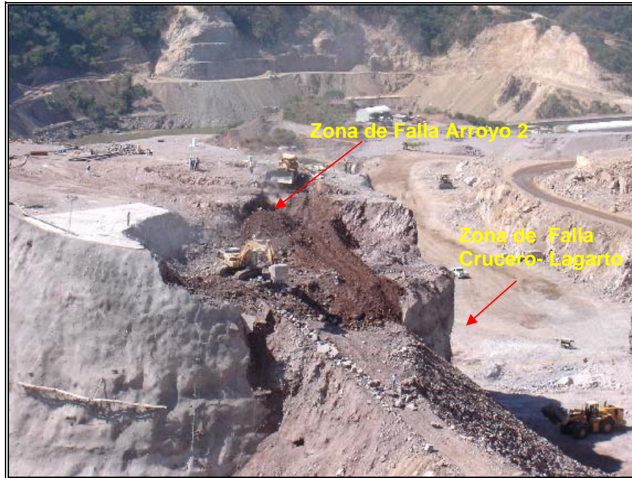
Fotografía IV.13. Vista de los trabajos de excavación realizados en el muro alabeado.
