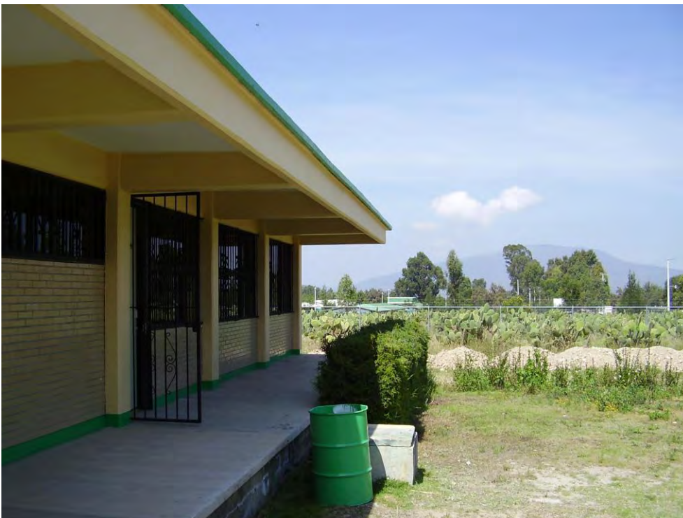
Edificio de laboratorios del Colegio de Bachilleres, Otumba
