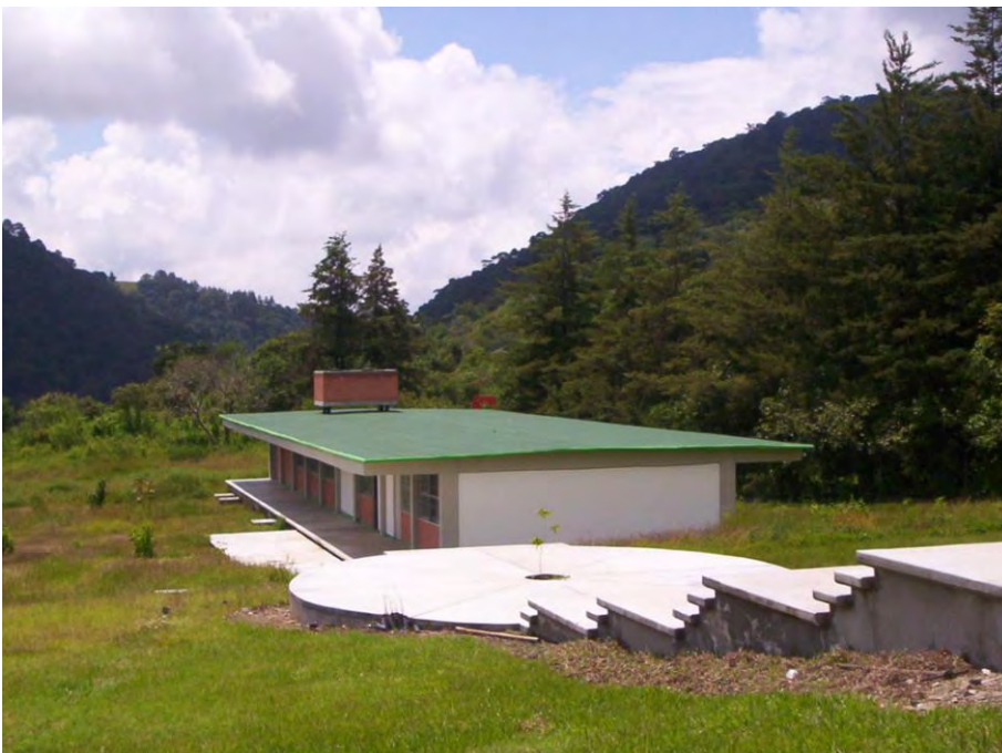
Nuevo edificio Municipio de Ixtapa de Oro, Estado de México
