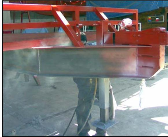
*Fig. 4.36 Aplicación de primario en el remolque.* >>>
