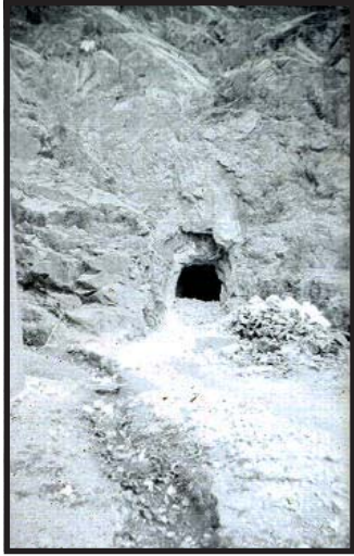
Fotografía 33. Construcción de túneles para conectar a la zona minera (material CIHV)
