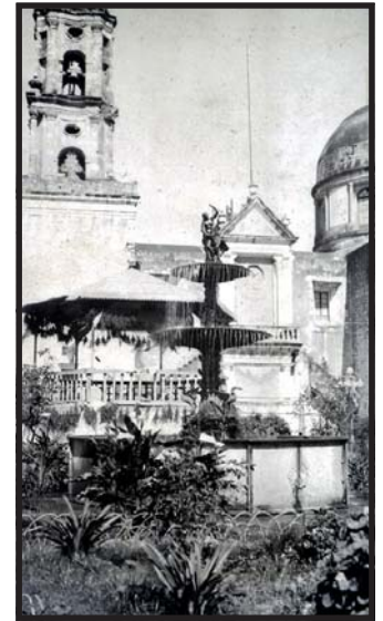
Fotografía 21. Parroquia de la Purísima Concepción, se construyó en el año de 1725. (material CIHV)
