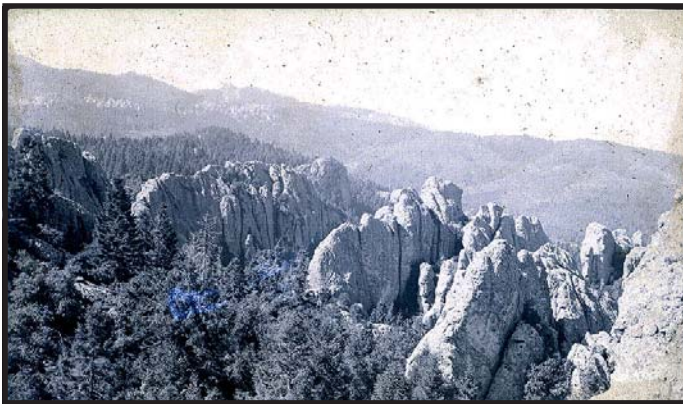
Fotografía 8. Toma de las formas caprichosas de un grupo de peña. (material CIHV)
