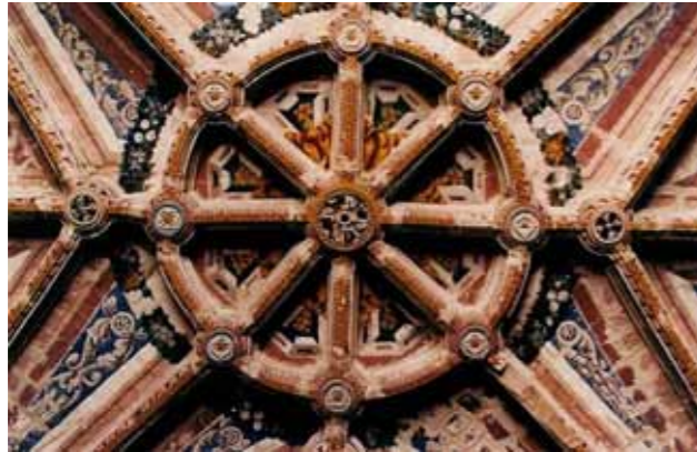
Arriba, Nervaduras y decoración de la bóveda que soporta el coro del templo en el conjunto conventual de Coixtlahuaca.
