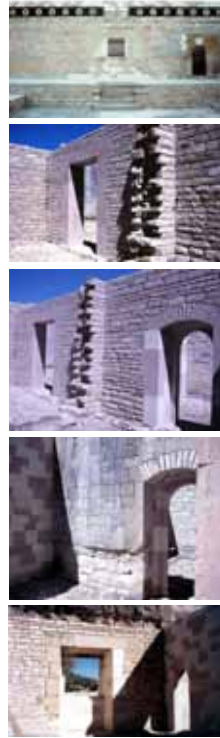
Interiores durante el proceso de prospección y restauración.
