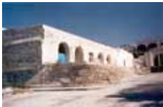
Fachada Sur casas consistoriales Autor: Norma Cortés 2004
