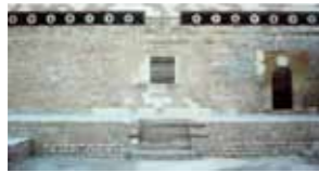
Fachadas norte y sur respectivamente del edificio principal del conjunto denominado Casa de la Cacica.
