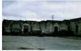
Vestigios tecpan Coixtlahuaca 1980 fachada Norte y parte de la edificación Oriente Autor: Vences Vidal
