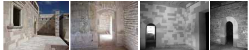
Interiores posteriores a la restauración.
