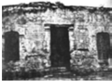
Fotografía fachada oriente Autor: Vences Vidal
