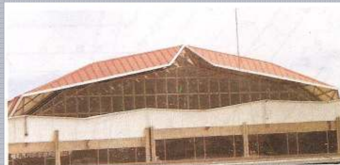
Fachada andenes terminal de autobuses Puebla.
