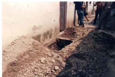
Excavación del pozo no. 3
