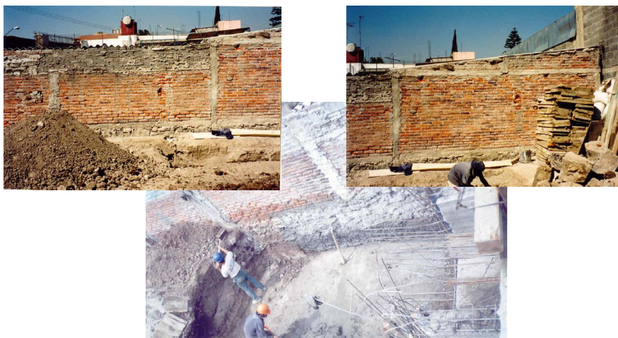
Fotos de Obra
