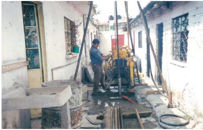
Extracción de muestra inalterada con muestreador de pared delgada "tubo shelby" en el SM-1
