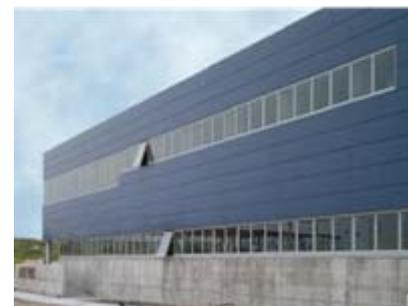
Fachada zona de consultorios CAM, Baja California. Materiales: ventanas con marcos de aluminio. Muros con paneles en color azul.
