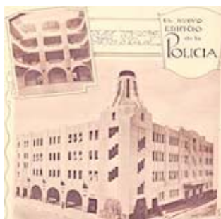
38. Edificio de Bomberos y Policía.
