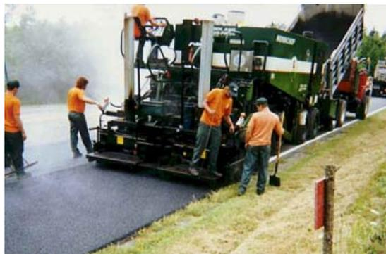
Fig. 11.- Tendido de carpeta asfáltica en caliente.
