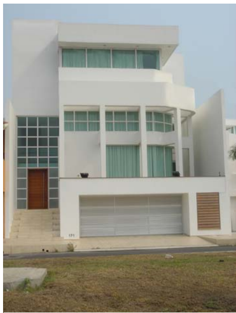
IMAGEN 100 Casa habitación localizada en Av. Boulevard del Mar.
