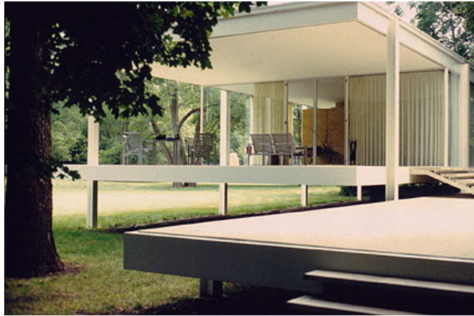
IMAGEN 27 Casa Farnsworth por Mies Van de Rohe. Illinois Considerada como su obra maestra. Empleo del muro cortina en su totalidad.
