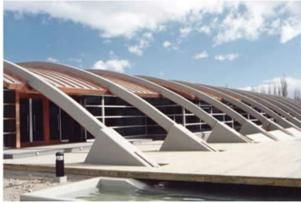
IMAGEN 61 Edificio de oficinas Patagonian
