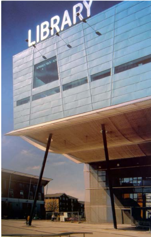
IMAGEN 90 Elemento rectangular que funge como protección solar.
