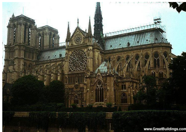
IMAGEN 3 Notre Dame, Paris. Obra ejemplar del gótico primitivo. Se presentan los cuatro niveles de arbotantes (arcada, galería, triforio y ventanas).
