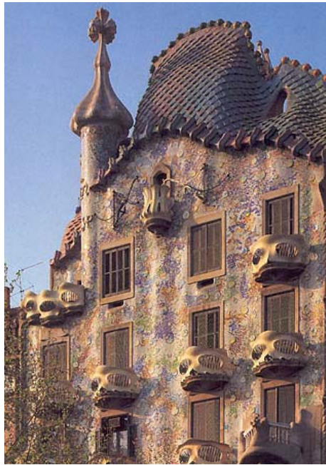
IMAGEN 15 Antonio Gaudí Cornet, Casa Batlló (Barcelona). Ornamentación como determinantes de la obra.
