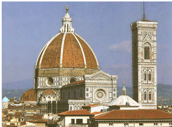
IMAGEN 6 Catedral del Florencia. La estructura de doble concha de cúpula fue una de las grandes innovaciones de este periodo de búsqueda.
