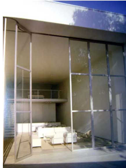
IMAGEN 38 Fachada posterior desarrollada como único volumen de 6 metros por 7 de ancho.
