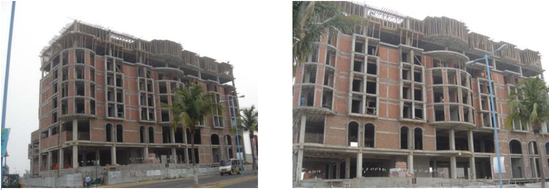
IMAGEN 105 Edificio en obra Negra, localizado enfrente a la Plaza Comercial Las Américas. Av. Las Américas casi esquina con calle Margaritas.
