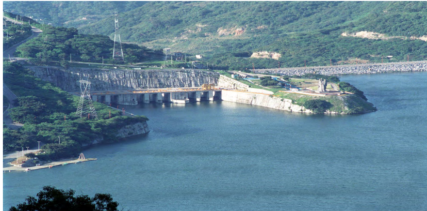
Figura 2.6 Planta hidroeléctrica Chicuasén Chiapas
