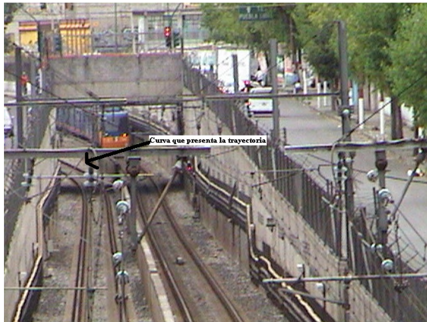
Figura 5.3 Curvaturas que se presentan en la trayectoria del tren y que tiene que vencer su resistencia
