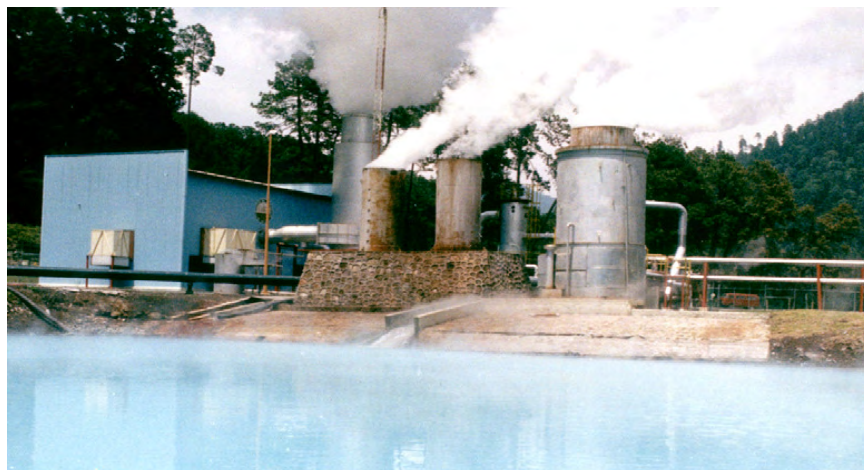
Figura 2.7 Planta geotermoelectrica Los Azufres Michoacán
