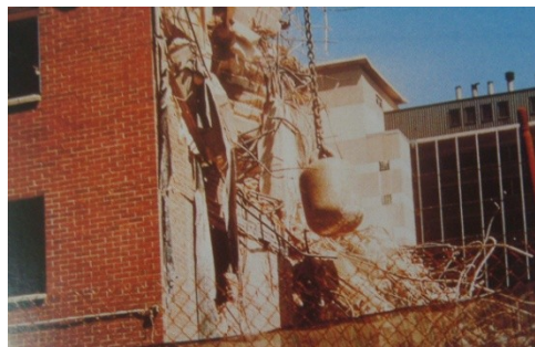
Fig. 60. Bola de demolición destruyendo un edificio de concreto. 12
