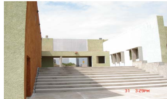
ACCESO INTERIOR HACIA EL EDIFICIO
