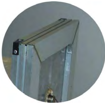
Foto 1. Perfil y placa remachados.
