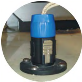
Foto 6. Conectores neutrick de la resistencia calefactora.
