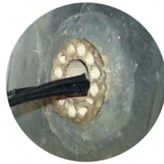
Foto 2. Ensamblajes sellados con silicón.
