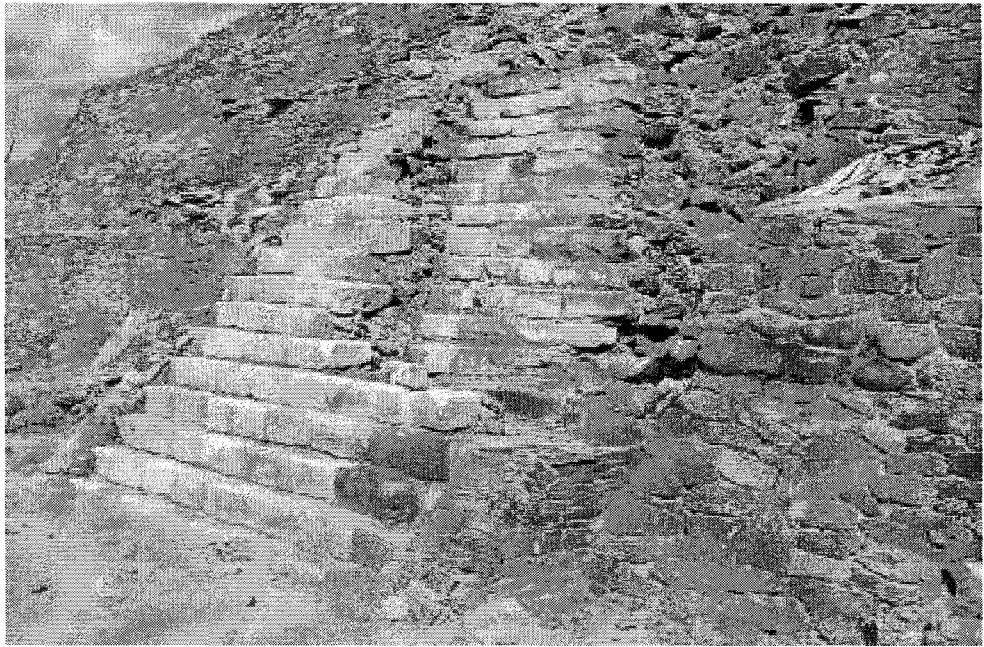
Fotografía 124. Sobreposición de escaleras en el basamento principal del complejo arquitectónico "B" del sector suroeste. (Foto: Alfredo Pérez Ponce).
