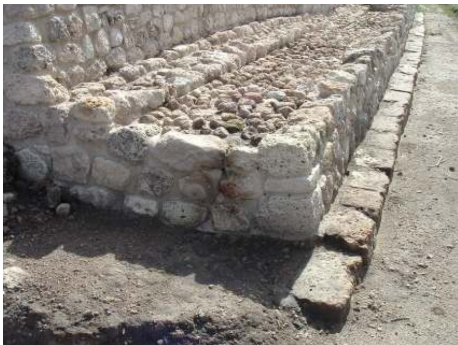
Fotografía 220. Cañada de la Virgen, Guanajuato; adición constructiva. FOTO: Alfredo Pérez Ponce.
