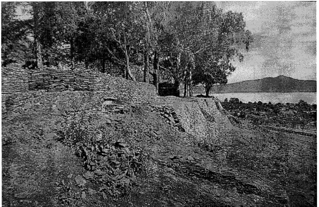
Fotografía 183. Extensión de superficies para edificación sobre la base de nivelaciones del terreno natural mediante plataformas realizadas con muros talud. FUENTE: Arqueología Mexicana, No. 73, Raíces, México, 2005, p. 83.
