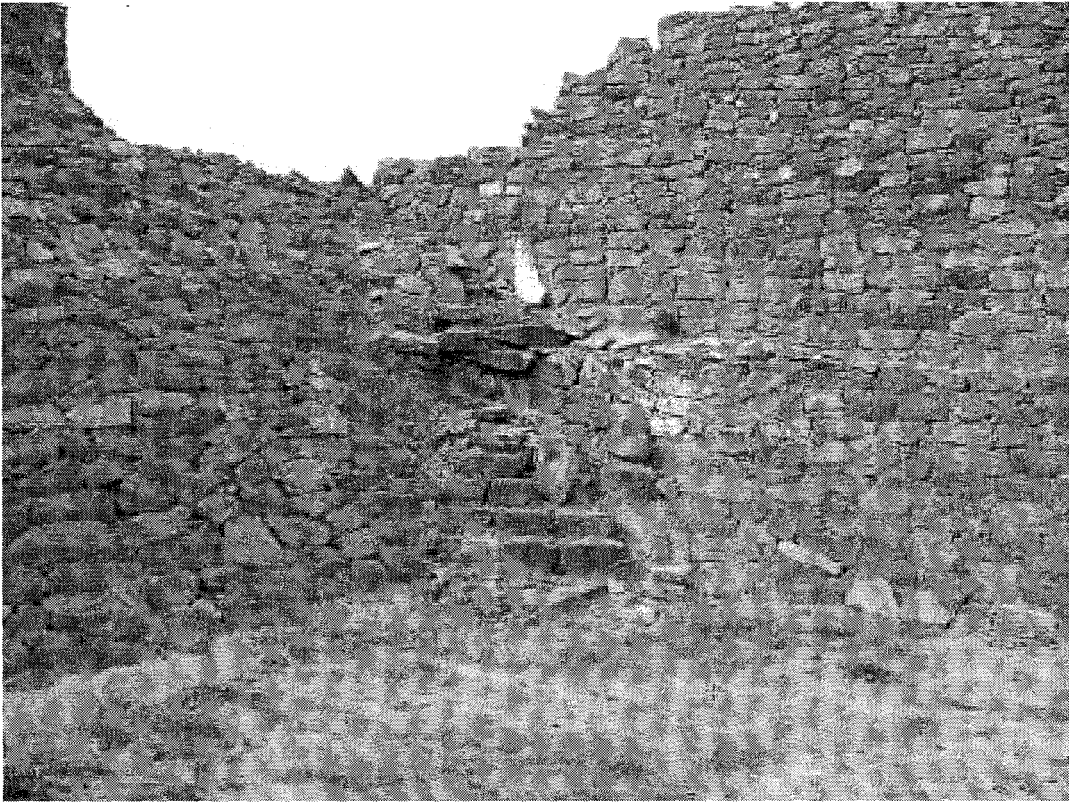
Fotografía 126. Escalera añadida en la parte externa de la esquina sureste del complejo arquitectónico "B", este elemento se adaptó a fin de permitir el acceso al patio hundido desde el exterior. (Foto: Alfredo Pérez Ponce).
