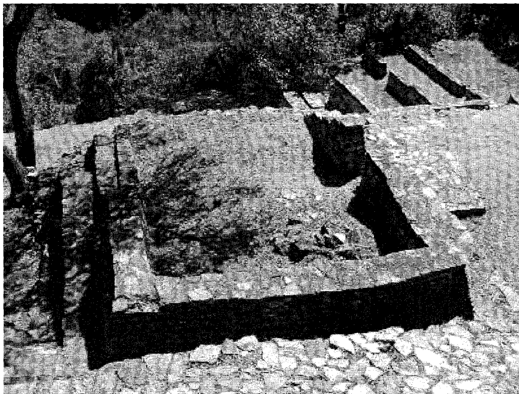
Fotografía 144. Las construcciones del asentamiento fueron logradas siguiendo el perfil natural del terreno, lo que finalmente se aprecia como un agradable escalonamiento del elemento arquitectónico. (Foto: Alfredo Pérez Ponce).
