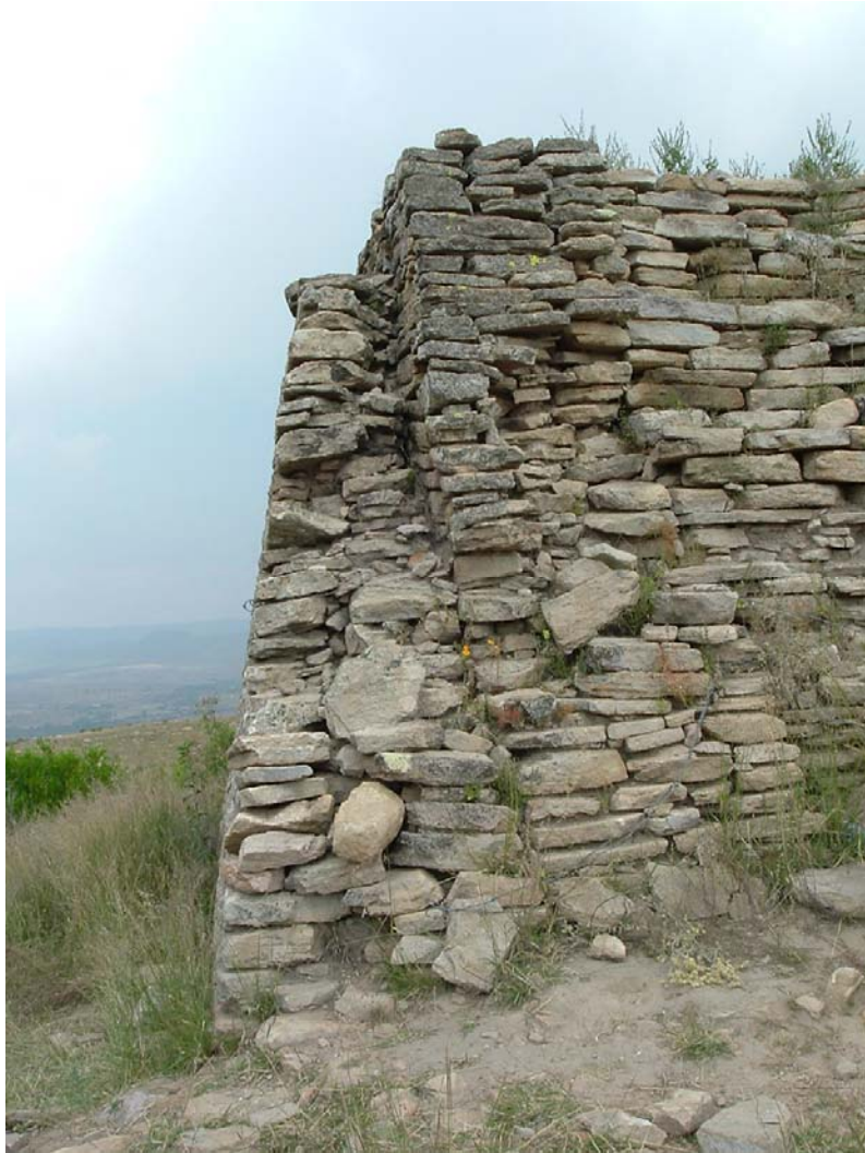
Fotografía 42. Un gran número de edificios presentan fallas constructivas, básicamente desplomes de muros, por lo que el contrafuerte corrido a manera de talud fue un recurso constante. (Foto: Alfredo Pérez Ponce).
