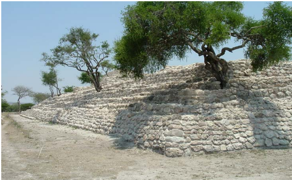
Fotografía 81. Esquina sureste de la plataforma que limita el espacio restringido y sostiene en su parte superior los aposentos, fue desarrollada mediante la sobre posición de muros verticales y en talud en el transcurso de tres etapas constructivas. Reproducción autorizada por el Instituto Nacional de Antropología e Historia (Foto: Alfredo Pérez Ponce).
