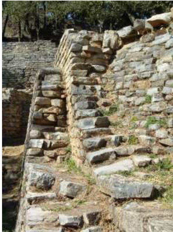
Fotografía 222. Ranas, Querétaro; adición constructiva. FOTO: Alfredo Pérez Ponce.
