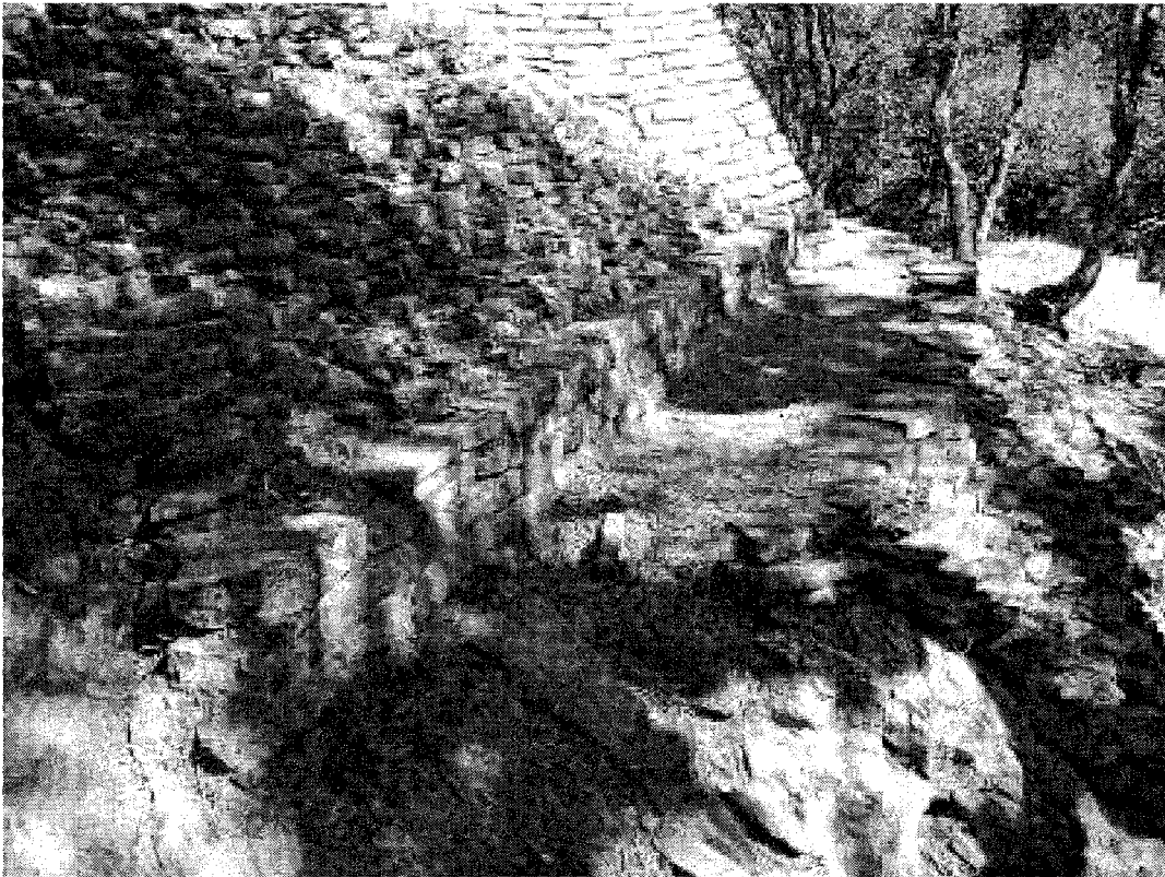
Fotografía 139. Las circulaciones secundarias del asentamiento se desarrollaron mediante angostos pasillo entre los mismos edificios. (Foto: Alfredo Pérez Ponce).
