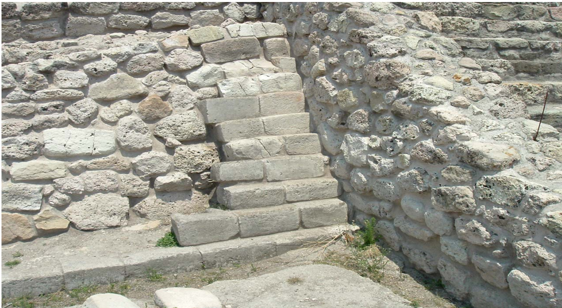
Fotografía 94. Vestigio del terminado en el talud exterior a manera de gradería, a la derecha la alfarda sur de la escalera principal de acceso al conjunto arquitectónico. Reproducción autorizada por el Instituto Nacional de Antropología e Historia. (Foto: Alfredo Pérez Ponce).
