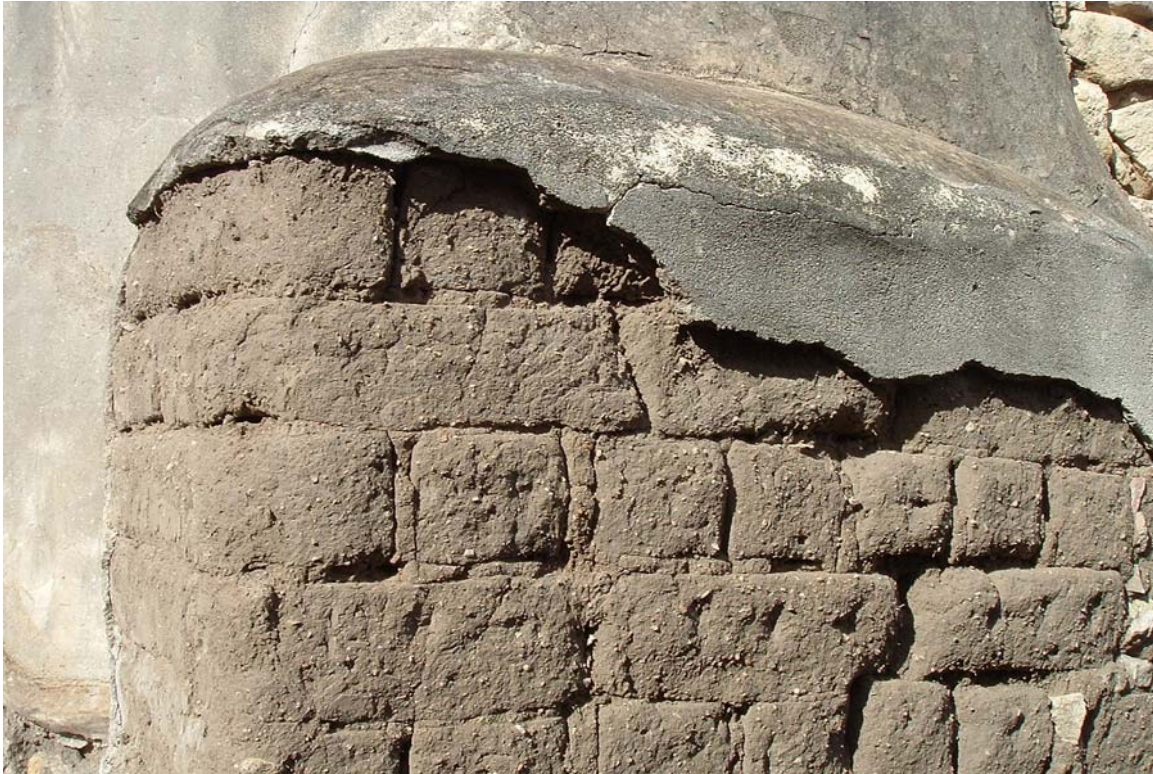
Fotografía 27. Muro interior elaborado a base de adobes. (Foto: Alfredo Pérez Ponce).
