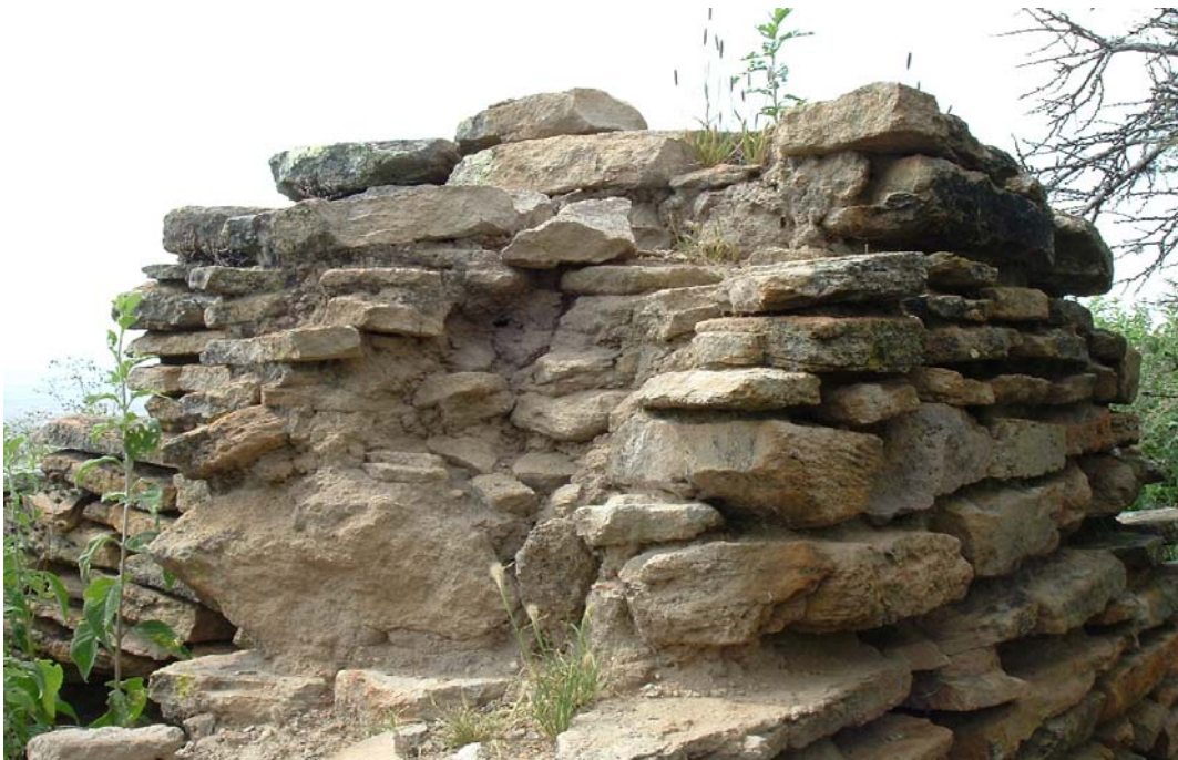
Fotografía 43. El sistema constructivo básico fue el muro de carga cuyo núcleo consistió en piedra, lodo y cal. (Foto: Alfredo Pérez Ponce).
