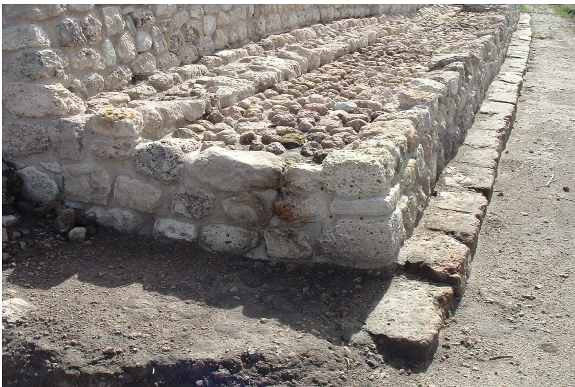
Fotografía 80. El sistema constructivo empleado para la ampliación de la plataforma perimetral consiste en rellenos de piedra y tierra encofrados por muros de piedra. Reproducción autorizada por el Instituto Nacional de Antropología e Historia (Foto: Alfredo Pérez Ponce).
