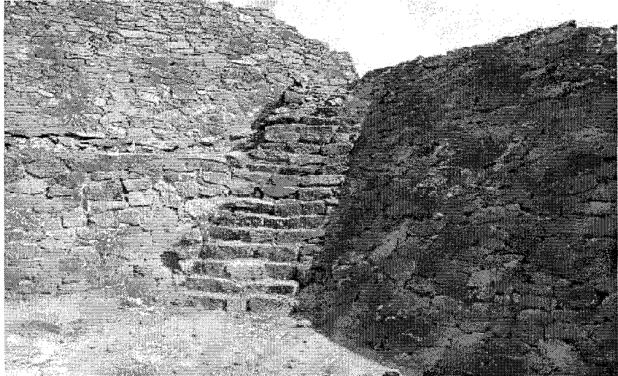
Fotografía 119. En la esquina sureste del complejo arquitectónico "B" del sector suroeste, se dispuso una escalera de acceso que, dadas sus dimensiones debió ser de uso restringido. (Foto: Alfredo Pérez Ponce).
