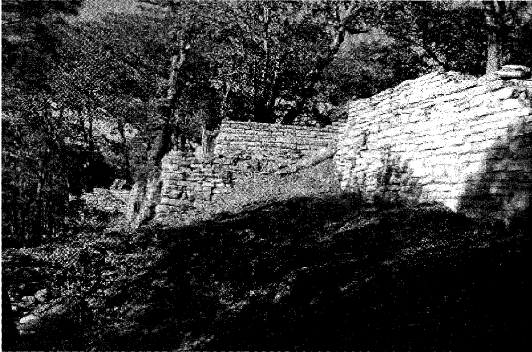
Fotografía 154. El perfil natural de la meseta fue modificado mediante terrazas soportadas por muros de contención, esto con la finalidad de acrecentar la superficie para desplantar los distintos edificios. (Foto: Alfredo Pérez Ponce).
