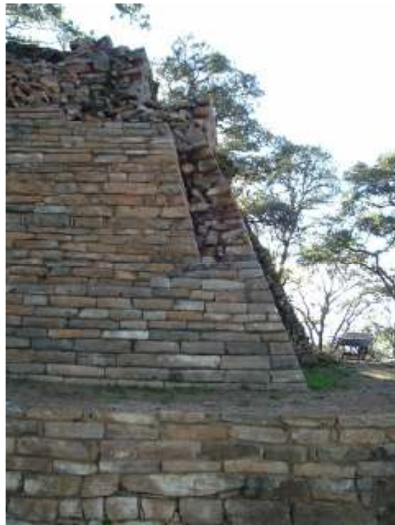
Fotografía 223. Toluquilla, Querétaro; adición constructiva. FOTO: Alfredo Pérez Ponce.
