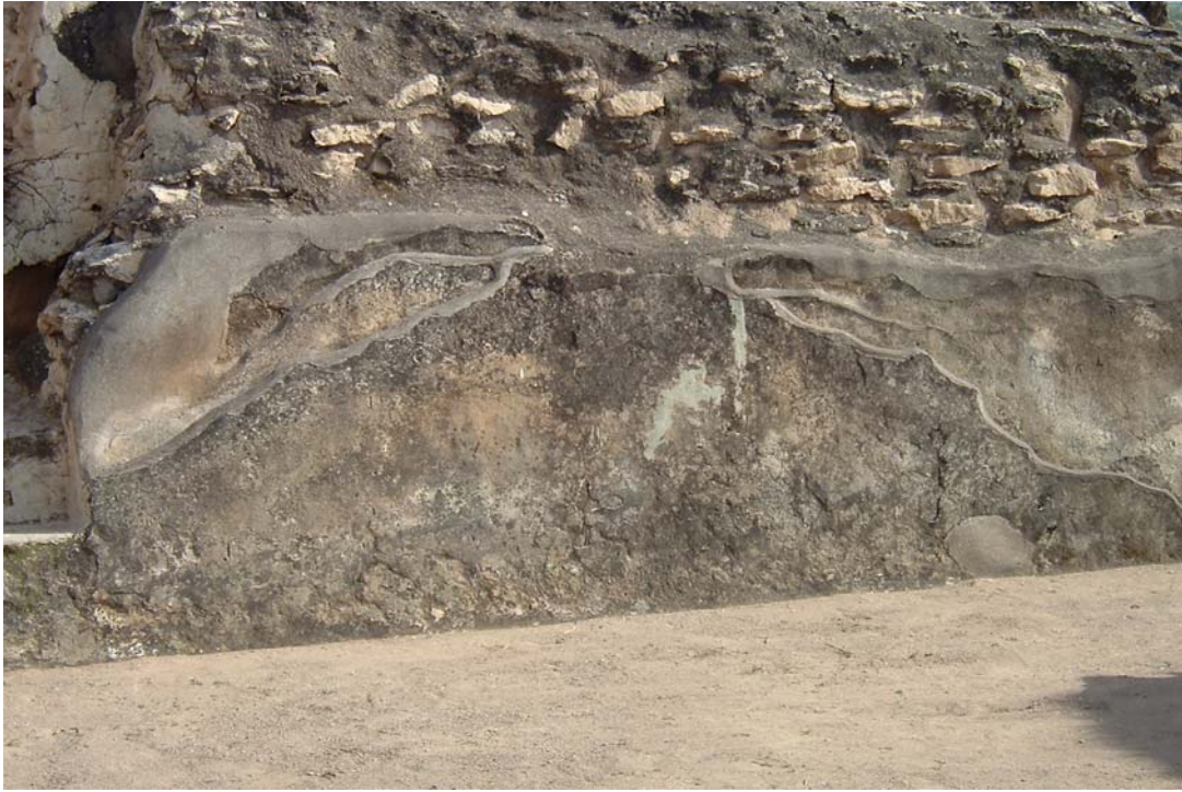
Fotografía 28. Muro elaborado a base de piedra, tierra con arcilla y cal, su acabado es de dos capas, la primera de barro con filamentos vegetales y la segunda de arcilla con cal. (Foto: Alfredo Pérez Ponce).
