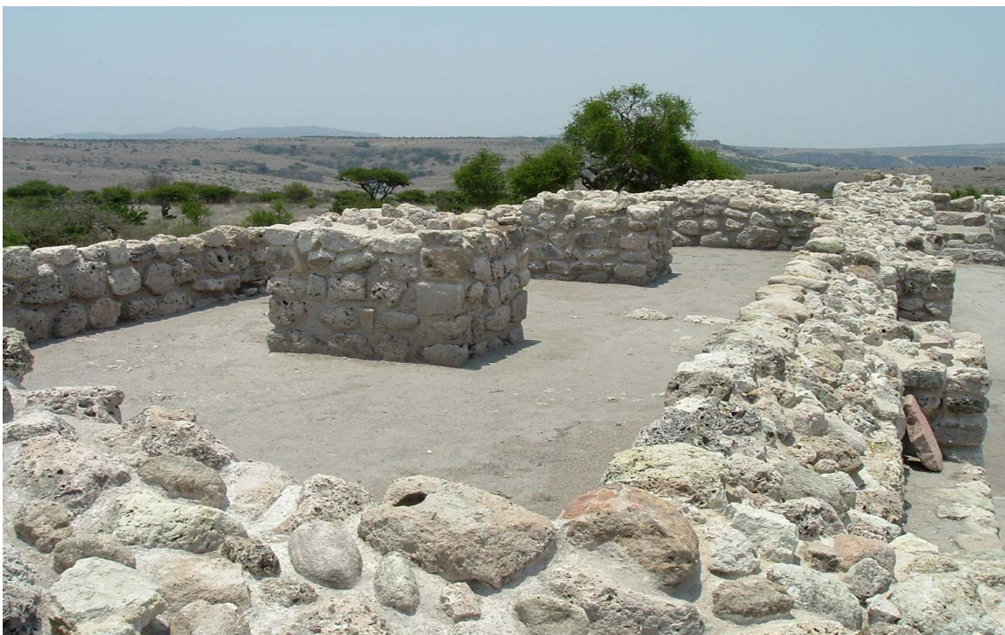
Fotografía 83. Los aposentos ubicados sobre las plataformas perimetrales del espacio restringido fueron construidos mediante muros y pilares de piedra. Reproducción autorizada por el Instituto Nacional de Antropología e Historia (Foto: Alfredo Pérez Ponce).
