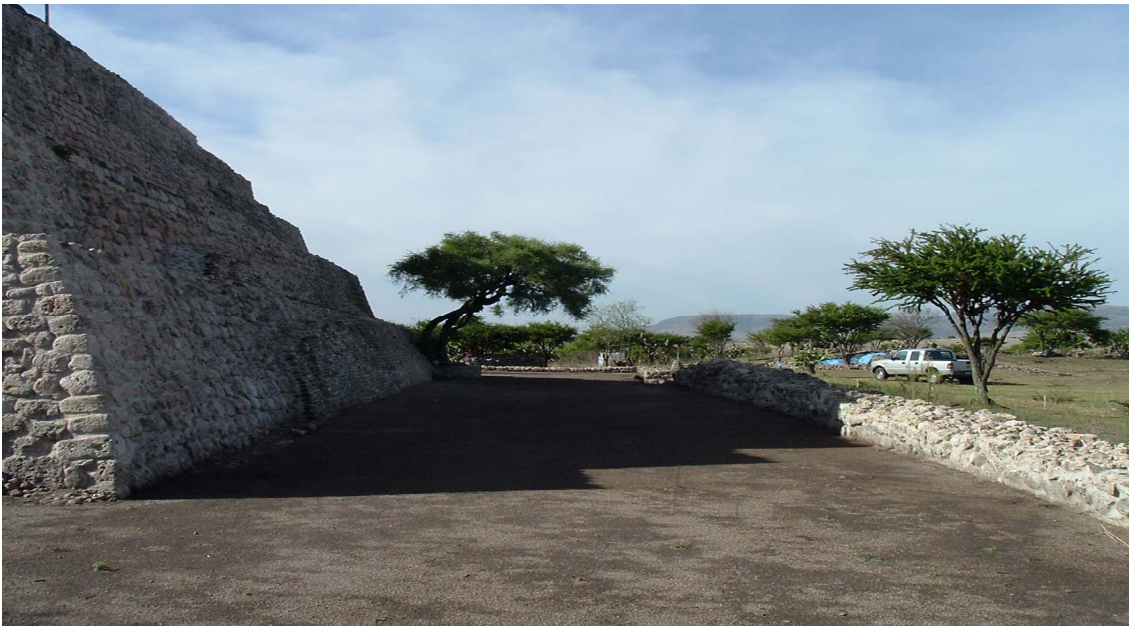
Fotografía 87. Muro perimetral que protegió el basamento troncopiramidal del exterior en sus costados norte, sur y oeste. Reproducción autorizada por el Instituto Nacional de Antropología e Historia (Foto: Alfredo Pérez Ponce).
