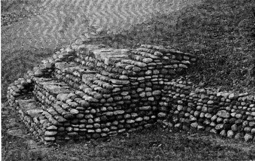
Fotografía 180. Construcción de talud, escalera y alfardas con piedra bola obtenida del río El Tampaón. FUENTE: Arqueología Mexicana, No. 79, Raíces, México, 2006, p. 81.
