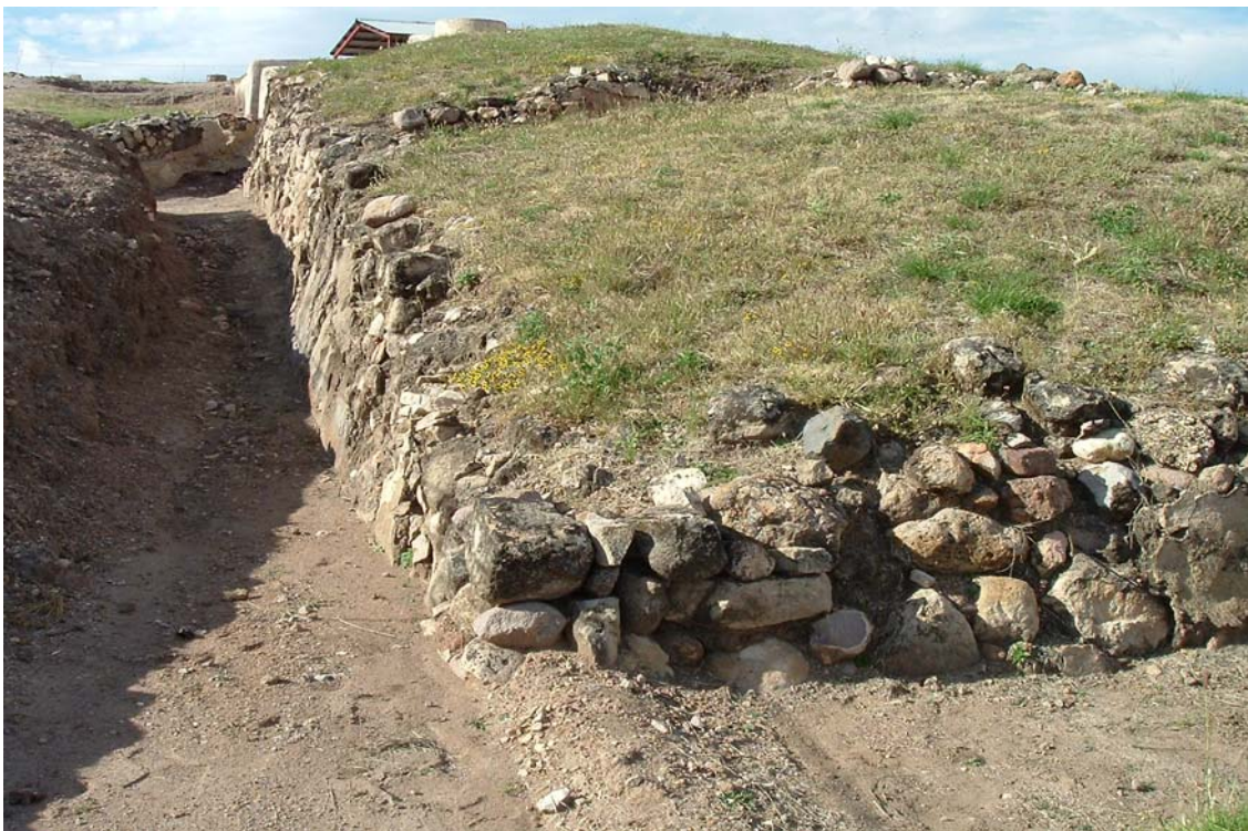
Fotografía 24. El terreno de tipo arcilloso facilitó el trabajo de excavación para la construcción del asentamiento, sin embargo, su poca resistencia y estabilidad originó movimientos y deformaciones en las estructuras arquitectónicas. (Foto: Alfredo Pérez Ponce).
