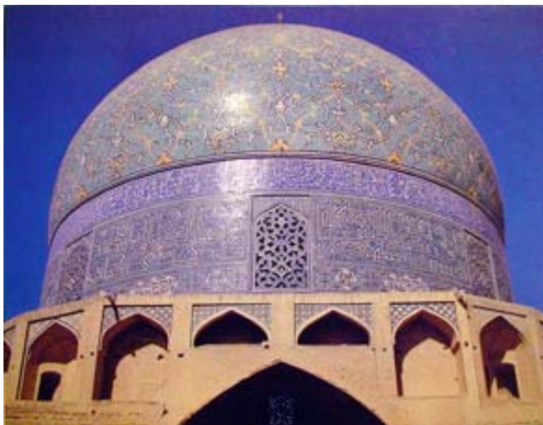
Figura 15a Cúpula de la Mesquita del Shah en Ispahán. Placas de Revestimientode loza esmaltada.
