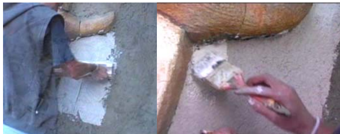
Figura 59 Aplicación de la argamasa con plana y aplicación de la lechareada con brocha
