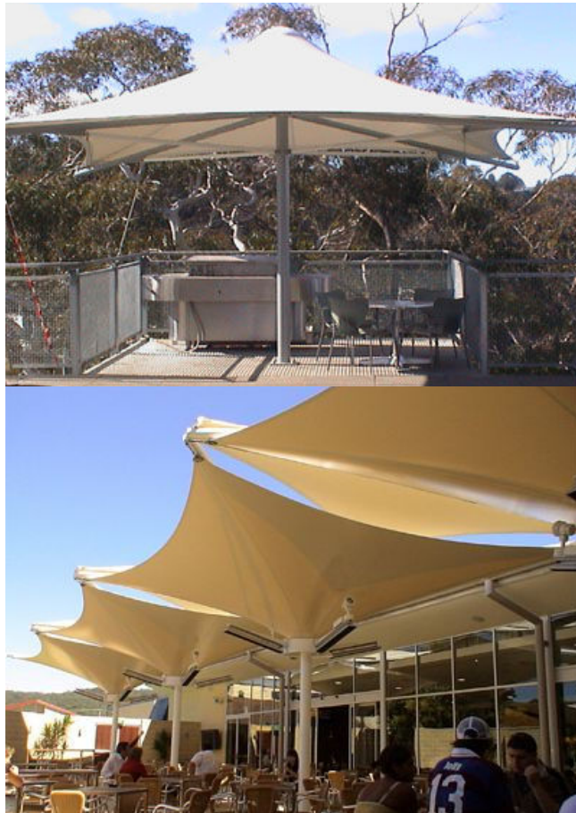
Fig. 111- Superior, Proyecto de Abacus Shadestructures , modelo de paraguas a partir de triángulos, en una membrana flexible.
