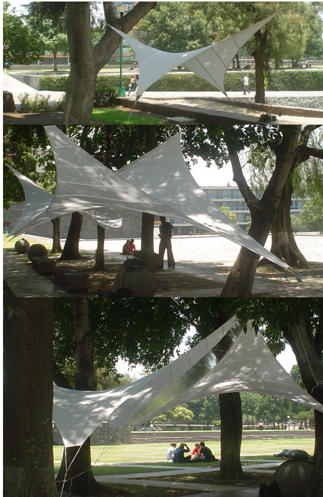
Fig. 74, 75 y 76- Ejercicio de velarias, realizado por alumnos de licenciatura en arquitectura. Los alumnos aprenden a generar las plantillas y crean sus propios modelos, los resultados estéticos y a nivel experimentación son notables. Fotos de Carolina Carmona D.R.
