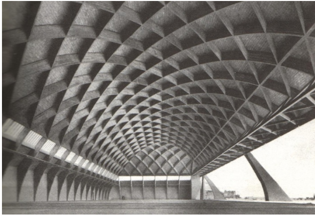
Fig. 16- Vista de uno de los hangares construidos por Nervi en Orbetello, Italia. Se puede ver la estructura geométrica romboidal y la columna inclinada que responde a la resultante de las fuerzas. Libraba sin apoyos grandes claros, por lo que sus obras resultaban muy económicas. Imagen extraída del libro: Pier Luigi Nervi, Reproducción con fines didácticos.
