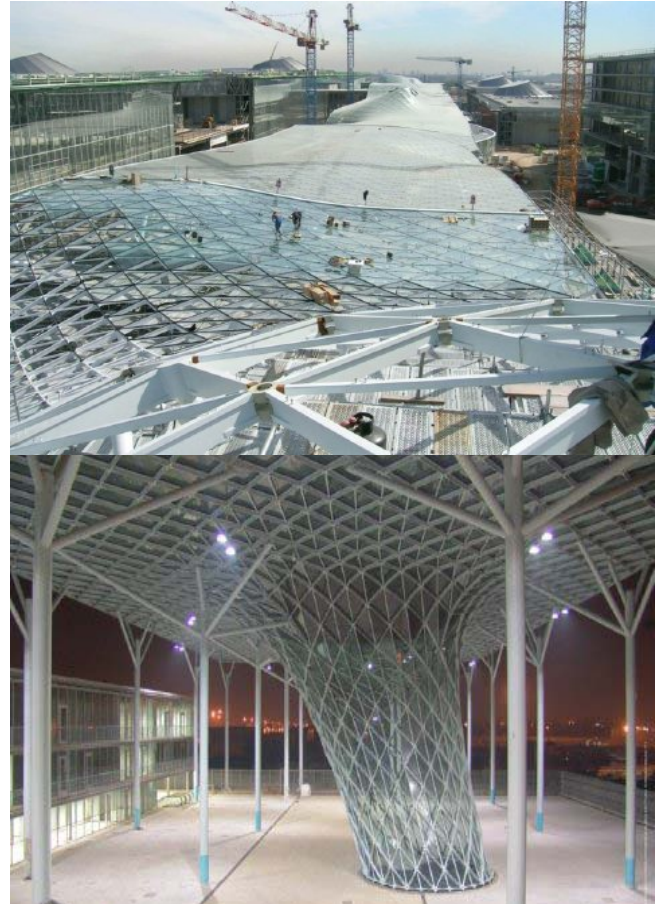
Fig. 30-Superior, se observa el proceso de construcción de la Vela Cubierta, y la generación de la doble curvatura en base a mallas. Foto extraída de la revista Space Structures,
