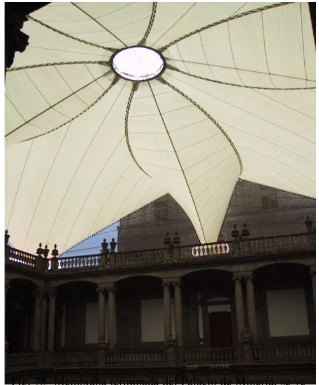
Fig. 73—Membrana terminada del Palacio de Minería, se ve en especial la linternilla del centro de la velaria. Foto proporcionada por Gerardo Oliva. Reproducción con fines didácticos
