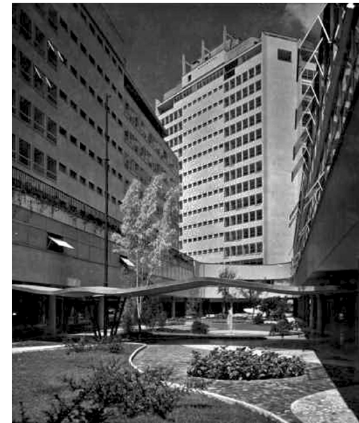
CONJUNTO ARISTOS. PATIO INTERIOR.
