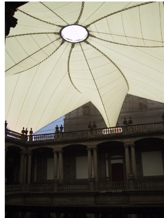
Img. 92 y 93. Cubierta del Palacio de Minería. Maqueta del proyecto y vista de la Cubierta, diseñada por el Dr. Gerardo Oliva.
