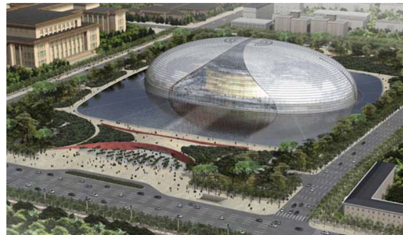
Img. 90. National Grand Theater_Beijing_Paul Andreu Architecte And
