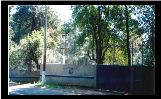
Imagen 33 Infraestructura.- Cuenta con todos los servicios necesarios como lo son: Subestación eléctrica, planta de agua y fosas sépticas donde se encuentran los servicios sanitarios.
