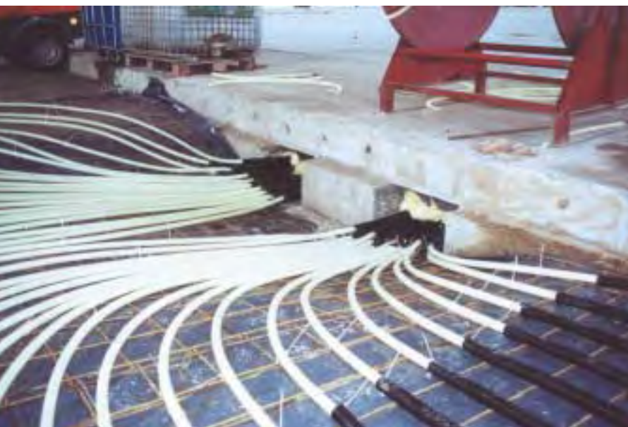
También en el ámbito de pavimentos calefactados se utiliza hormigón armado de fibra por su rápido comportamiento de regulación. Para estabilizar su posición, los tubos de calefacción se fijan a una armadura ligera de esteras.
