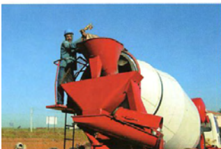
Las fibras se incorporan durante el proceso de mezcla en planta o dentro de la hormigonera
