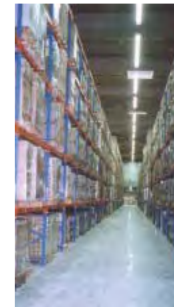
Los suelos industriales modernos de hormigón armado de fibra se caracterizan por su elevada capacidad portante, su alta resistencia a la fisuración y su durabilidad.
