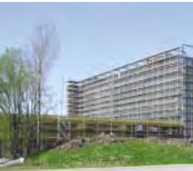
La presión de plazos y costes está a la orden del día en las inmobiliarias. El hormigón armado de fibra, p.ej. como capa de hormigón sobre losas prefabricadas, suele ser una interesante alternativa.
