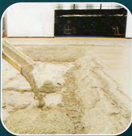
Pisos y pavimentos
