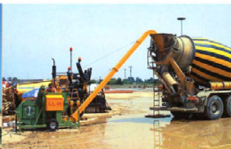
Las fibras se incorporan durante el proceso de mezcla en planta o dentro de la hormigonera
