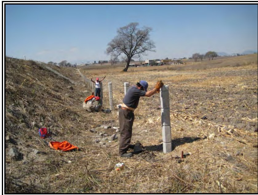
Figura 14. Reparación de Cercado del Derecho de Vía
