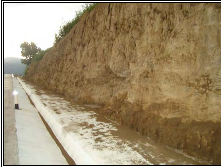
Figura 48. Banqueta al pie del Talud
