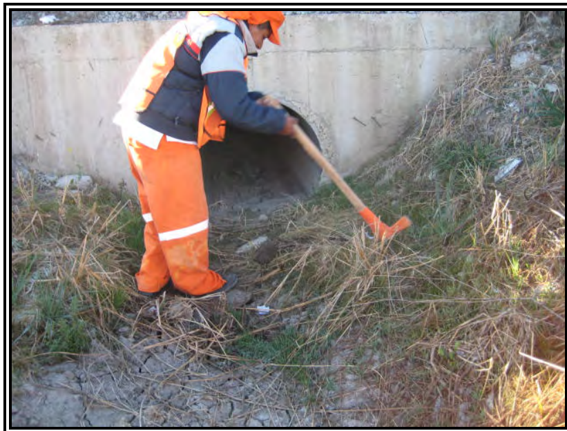
Figura 16. Limpieza y/o Desazolve de Alcantarillas
