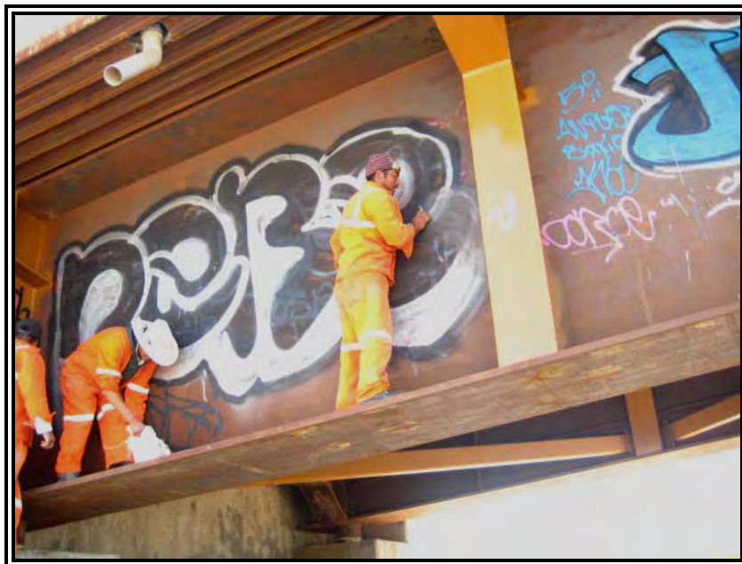
Figura 24. Limpieza De Grafito En Estructura Rama 2
