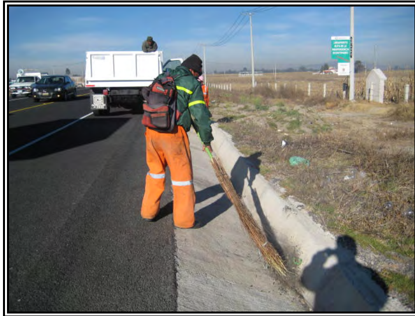
Figura 17. Limpieza y/o Desazolve de Cunetas
