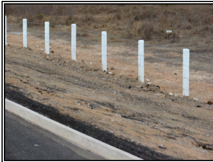
Figura 3. Bordillo a la orilla de la calzada
