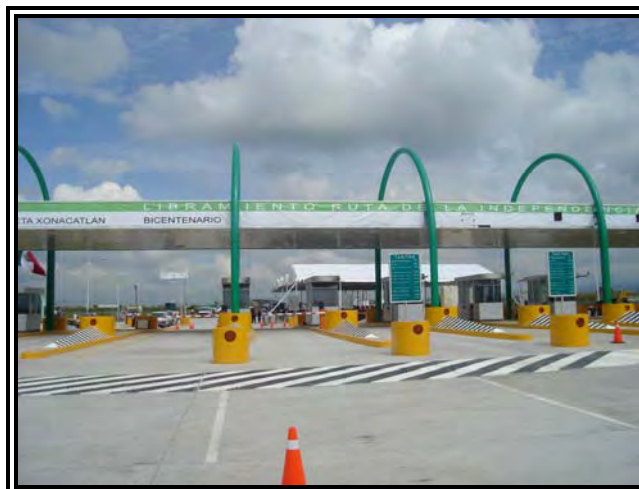
Figura 27. Caseta Xonacatlan troncal entronque Toluca-Naucalpan km 19+000 del Libramiento Nor-oriente de Toluca.
