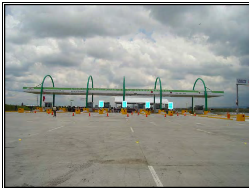
Figura 29. Caseta Xonacatlán Troncal. Vista del Faldón y Carriles de Circulación
