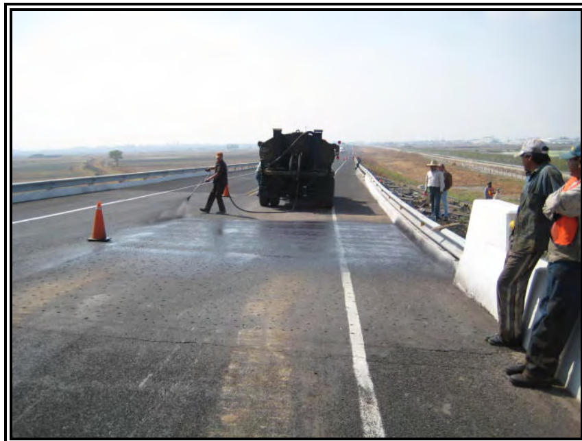
Figura 22. Riego De Liga Entrada Pte. Dren Ameyalco
