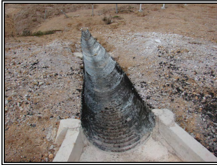
Figura 4. Lavadero de sección circular
