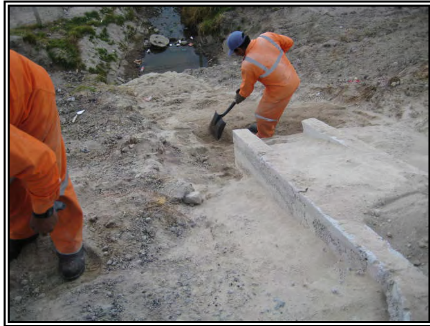
Figura 19. Limpieza de Lavaderos
