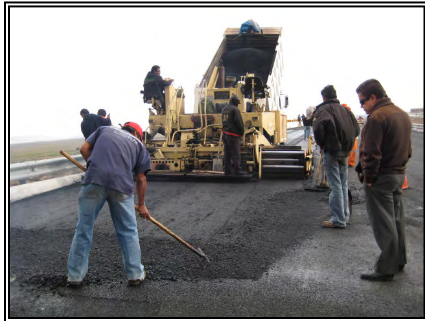
Figura 23. Tendido de Mezcla Asfáltica
