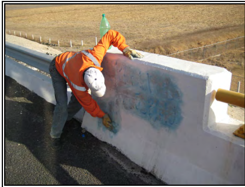
Figura 13. Limpieza de Guarniciones en Puentes
