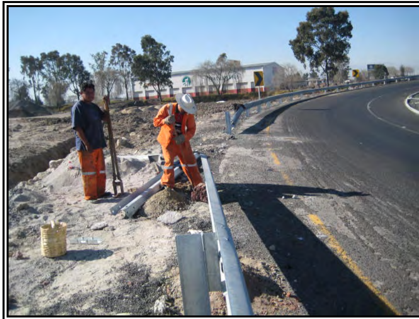
Figura 11. Sustitución de Defensa Metálica
