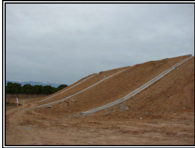
Figura 8. Talud en Terraplén con lavaderos de concreto
