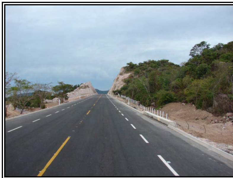
Figura 2. Calzada de una Autopista
