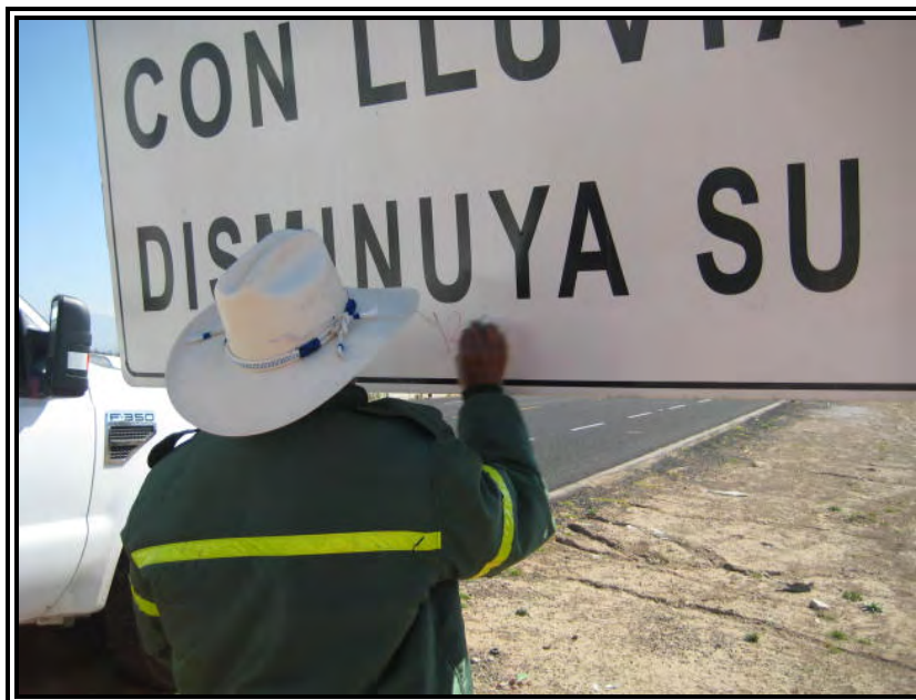
Figura 12. Limpieza de Señalamiento Vertical Bajo
