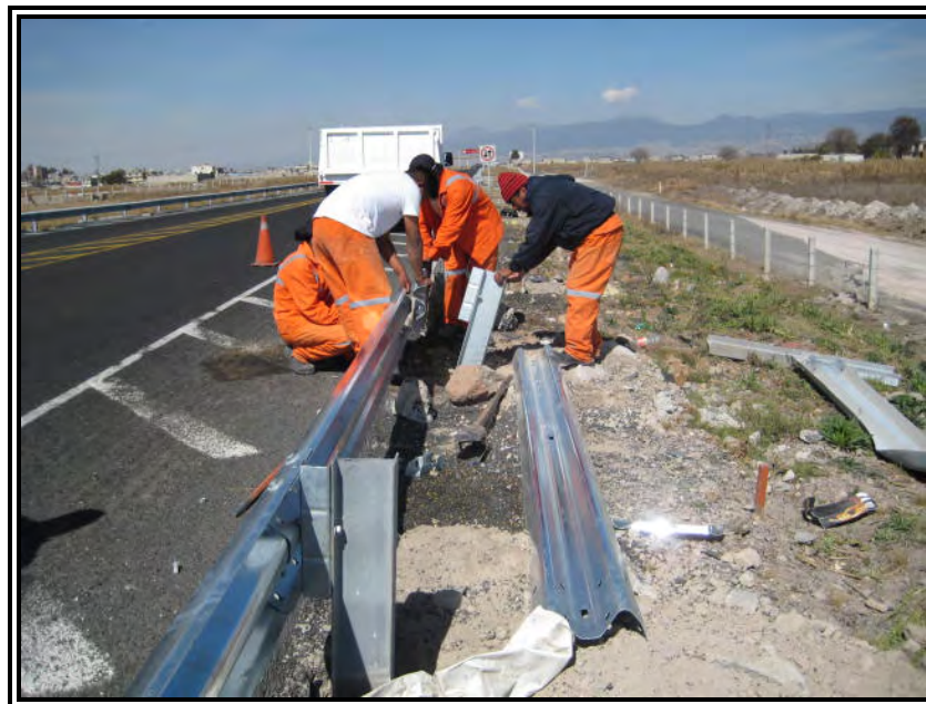
Figura 18. Reparación y sustitución de Defensa Metálica de Protección
