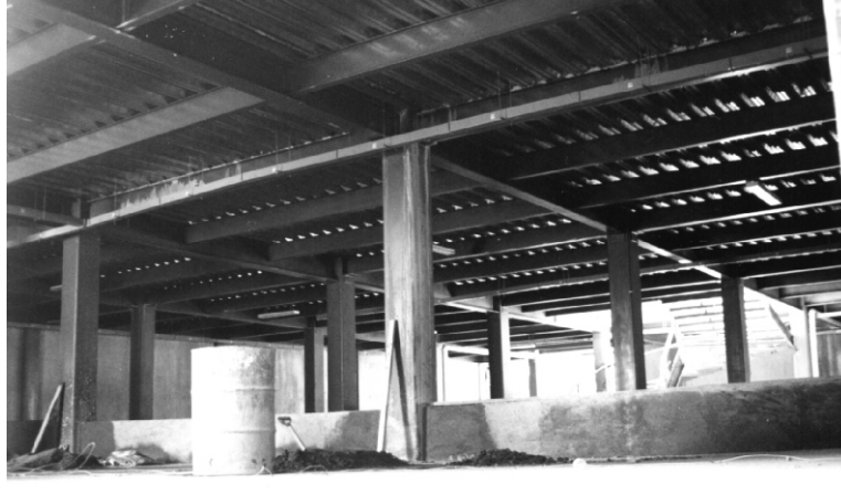
76.- Edificio en construcción para reubicación de puesteros (2005).
