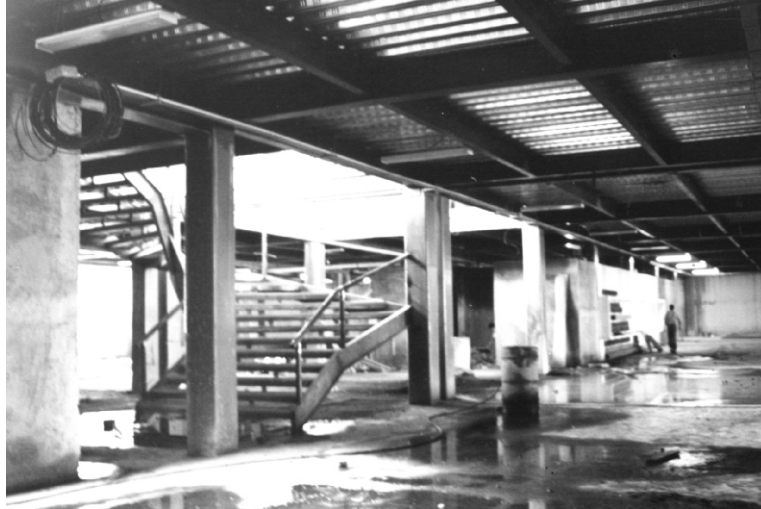
81.- Edificio en construcción para reubicación de puesteros (2005).
