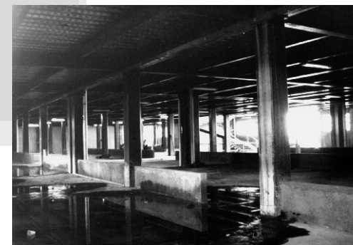
82.- Edificio en construcción para reubicación de puesteros (2005).
