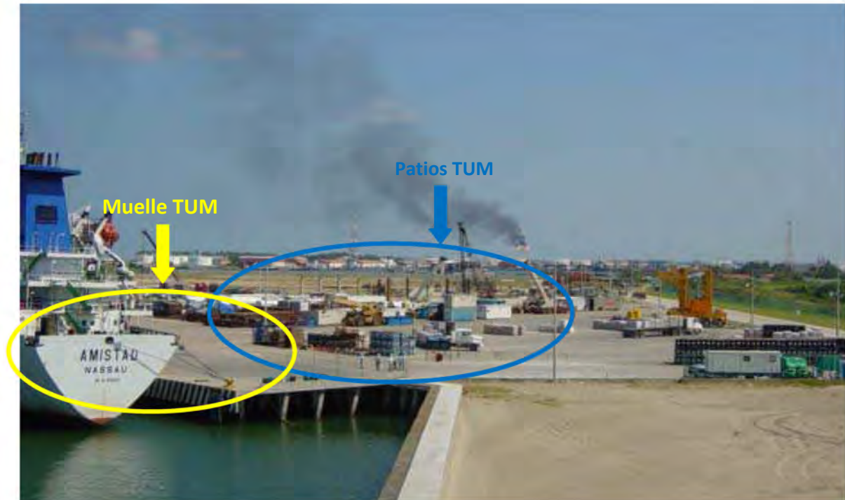
Fig. 1.16. Instalaciones del área comercial.
