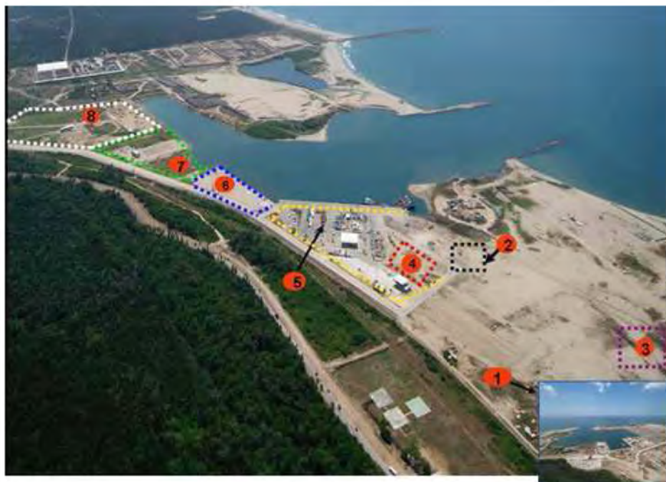
Fig. 1.10 Instalaciones del área comercial.
