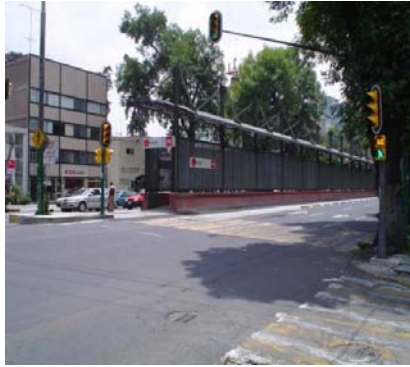
11 VISTA ESTACION DE METROBUS FRANCIA
