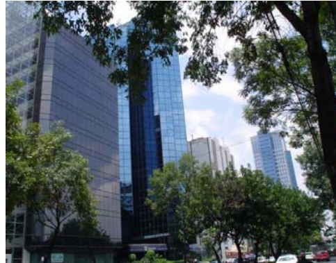
12 VISTA EDIFICIOS CRUZANDO GUSTAVO E. CAMPA SOBRE INSURGENTES
