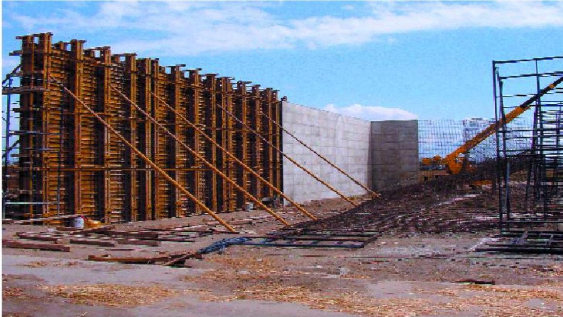
*Figura 5. Construcción de almacenes con concreto autocompactable.*
