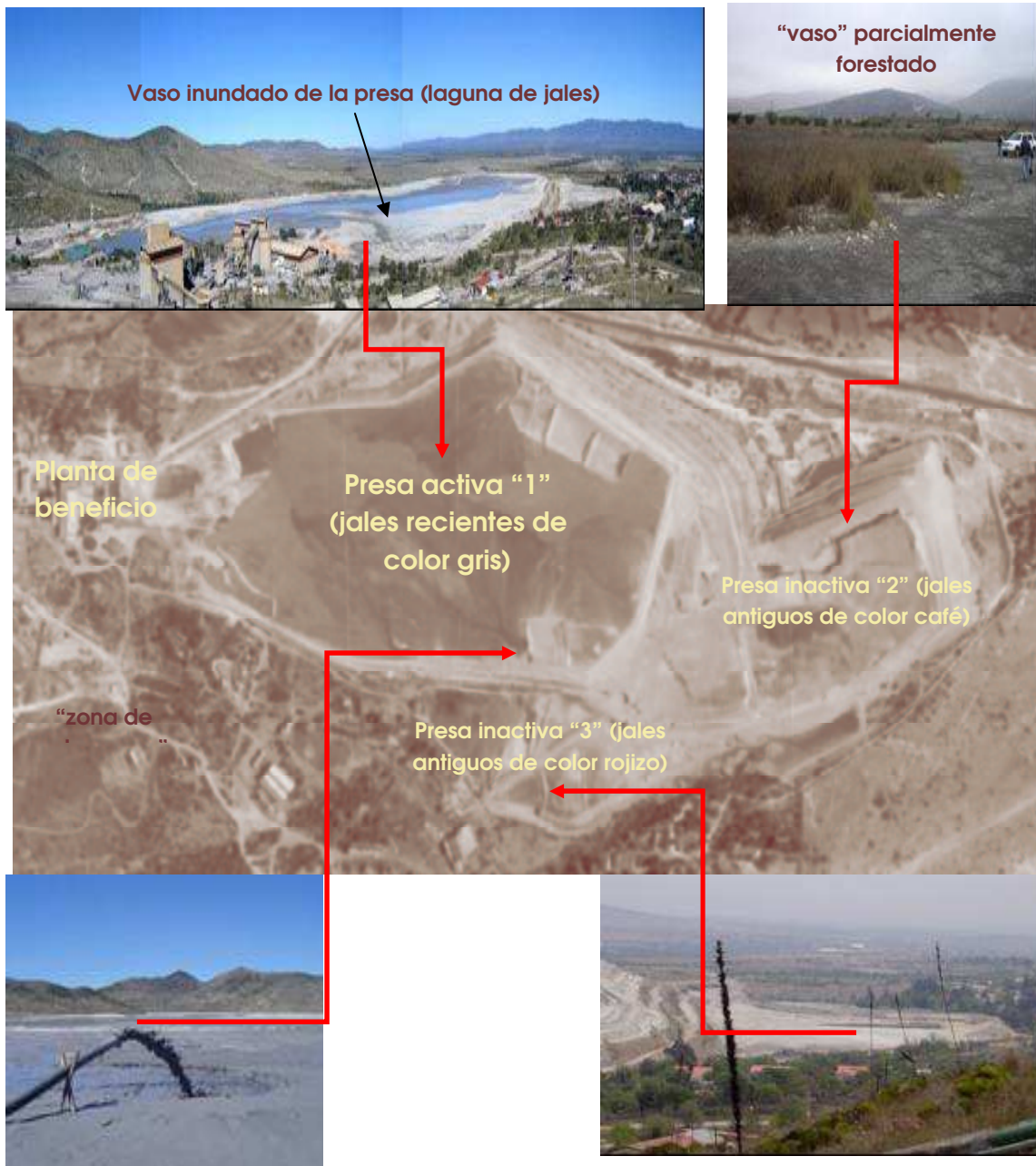
Figura 10. Aspectos generales de la presa de jales de la Unidad Minera Charcas (UMCh)
