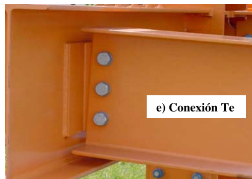
Figura 2.4 Conexión a cortante directo (Murray, 2001)
