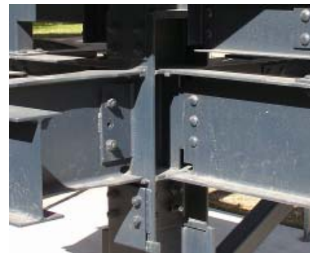
b) Conexión con patines soldados
