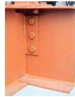
Conexión a cortante
