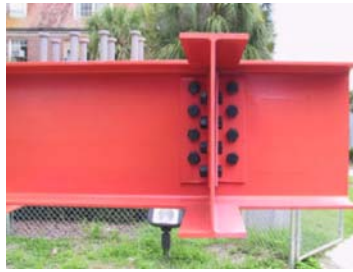
Conexión doble ángulo a) TIPO A
