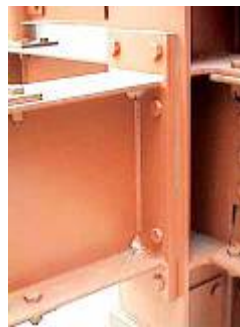
Conexión de placa extremo extendida
