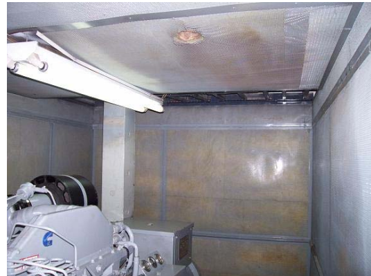
Figura 5.13. Entrada de aire frío directamente a la planta
