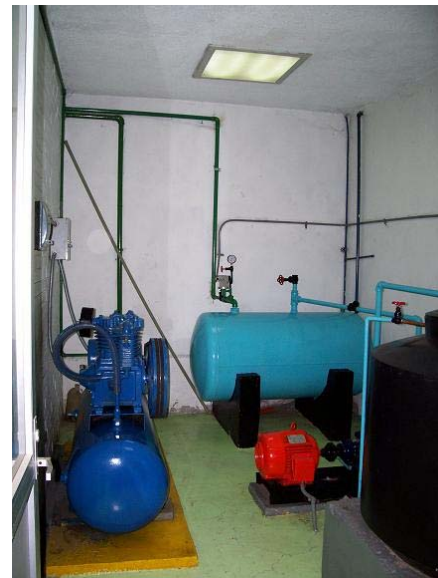
Figura 2.10 Del edificio principal
