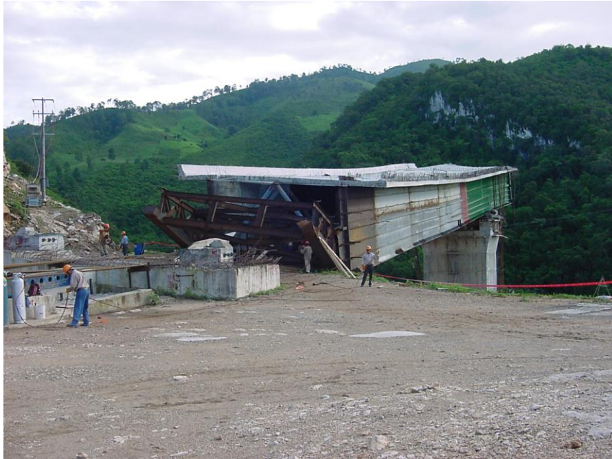
VISTA DEL LADO TUXTLA, ANTES DE LA DEMOLICIÓN
