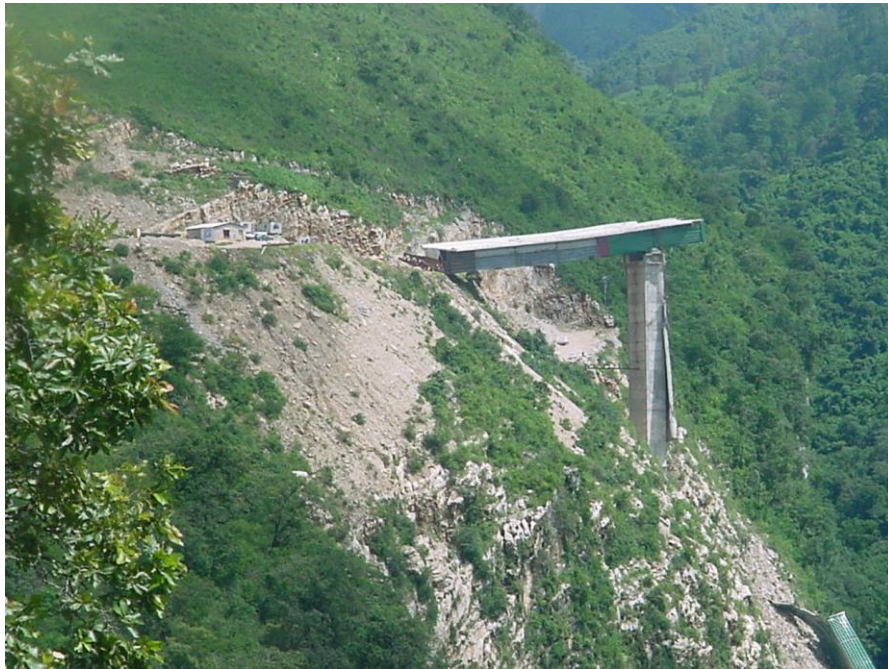
LADO TUXTLA ANTES DE LA DEMOLICION
