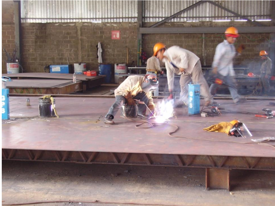
EL PERSONAL EQUIPADO CON CASCO, GANTES Y MASCARILLA PARA SOLDAR.
