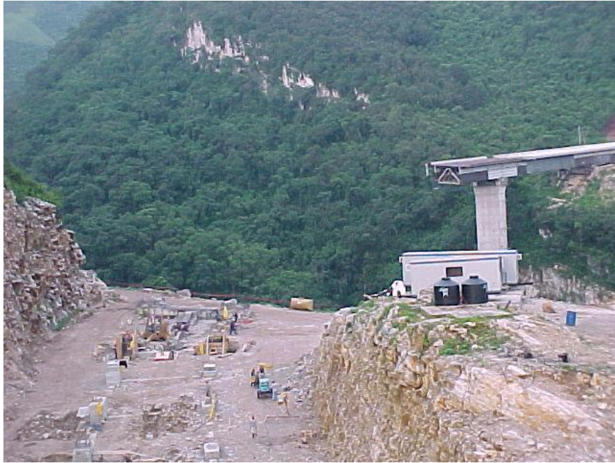
ZONA TUXTLA, ANTES DEL ARMADO Y MONTAJE DE SUS RESPECTIVAS DOVELAS
