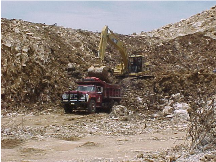
RETIRO DE MATERIAL
