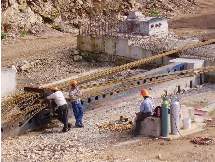
CABLES DE REFUERZO EN LOSAS
