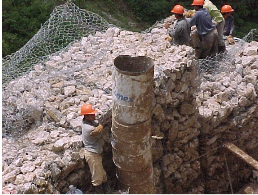
GAVIONES COLOCADOS EN LA BASE DE LA PILA PARA LA PROTECCIÓN DEL TALUD
