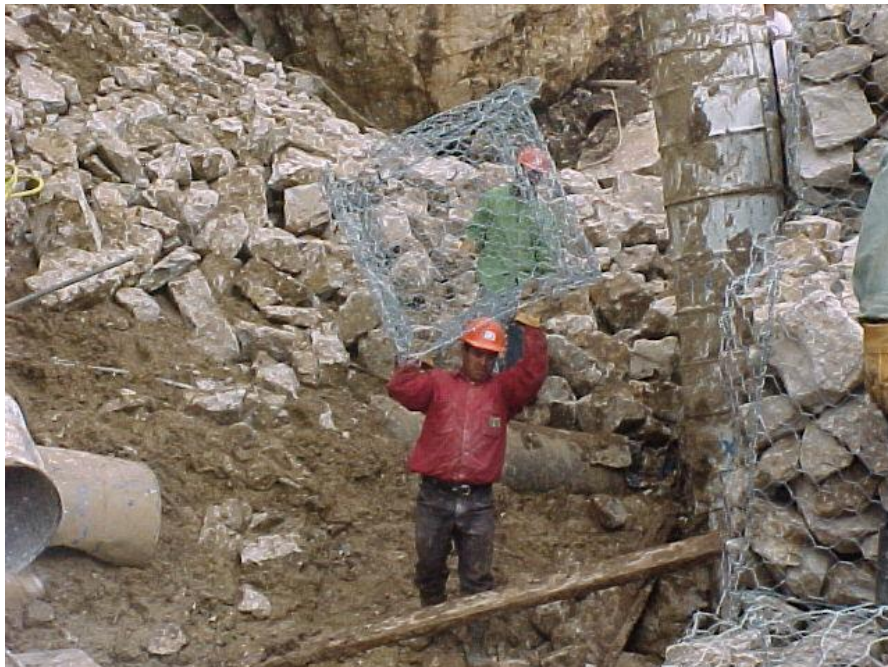
ARMADO Y COLOCACIÓN DE MUROS GAVIONES
