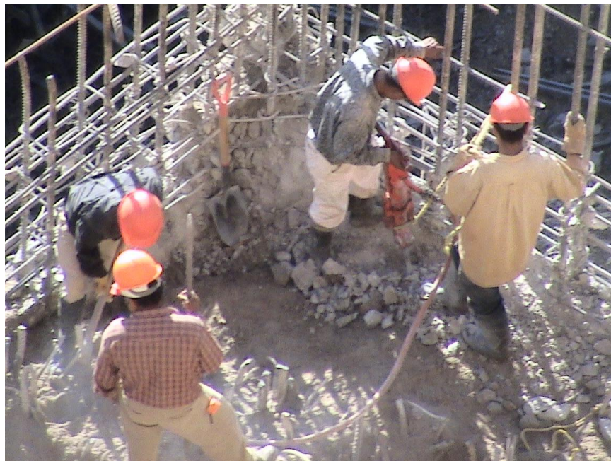
REHABILITACIÓN DE ARMADO
