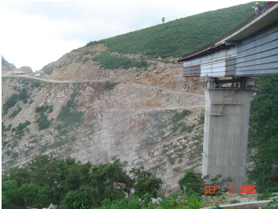
DESPUÉS DE LA DEMOLICIÓN
