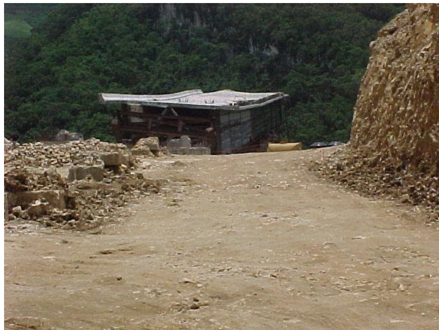
ESTRUCTURA ANTES DE DEMOLERSE
