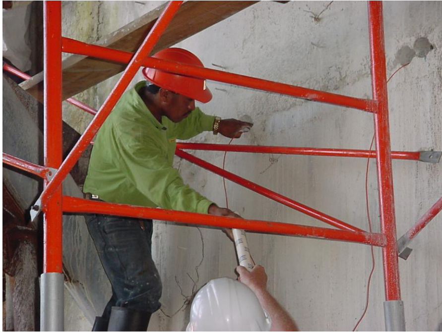
COLOCACIÓN DE LOS EXPLOSIVOS
