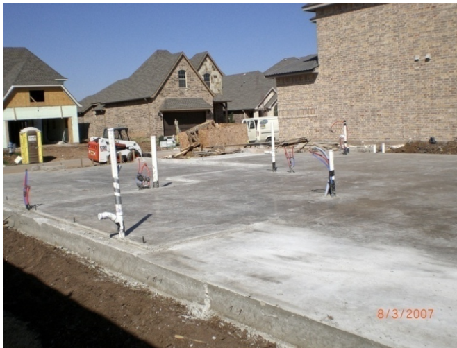
Fig. No. 13. Losa de cimentación terminada.
