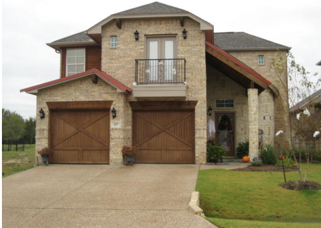
Fig. No. 31. Vista de la fachada principal.
