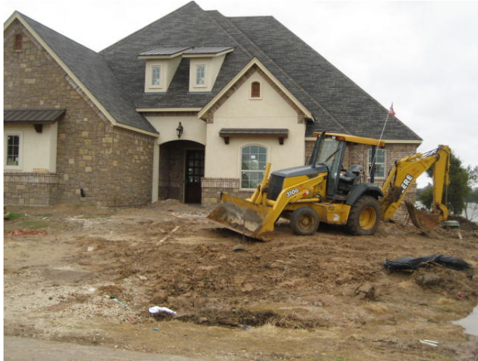
Fig. No. 2 Una retro mixta, se usa para excavaciones pequeñas.
