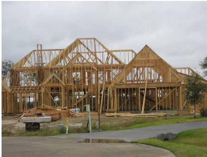
Fig. No. 6. Vista general del armado de estructura ligera.
