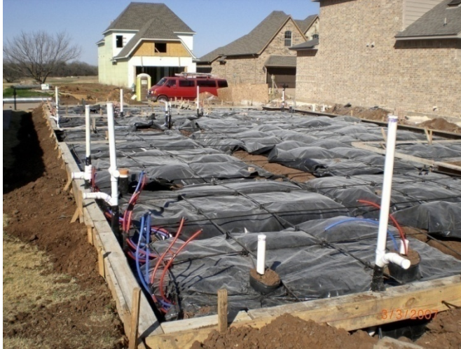
Fig. No. 12. Cubierta de poliuretano y armado y preparación de la losa de cimentación.
