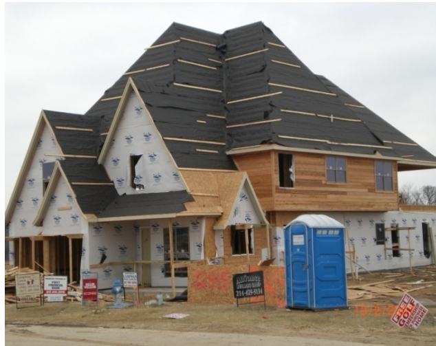
Fig. No. 21. Paredes de la estructura cubiertas con poliuretano y techumbre cubierta con papel asfaltado.
