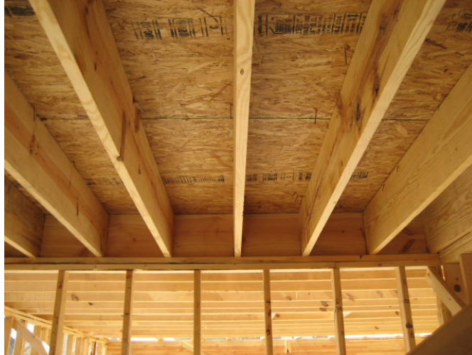
Fig. No. 19. Vista del armado de vigas de 2"x 6" y sobre estas, las hojas de triplay, que serán el piso del siguiente nivel.
