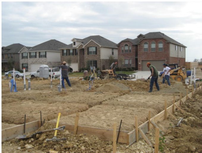
Fig. No. 11. Excavación de las trincheras de la cimentación.
