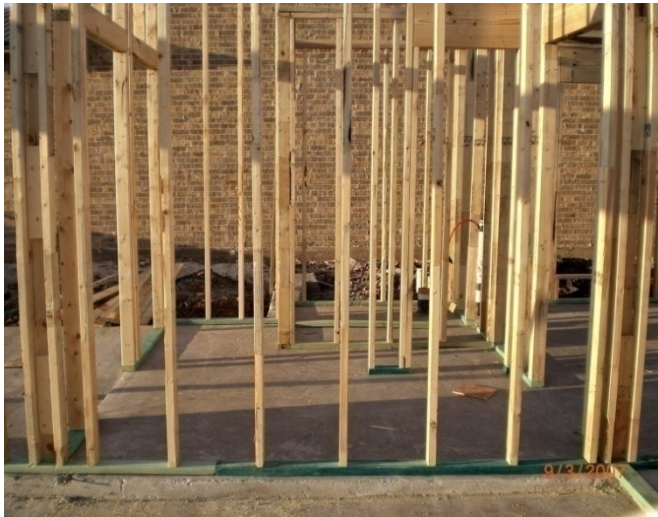
Fig. No. 14. Desplante de puntales 2"x4", sobre un riel de 2"x4".
