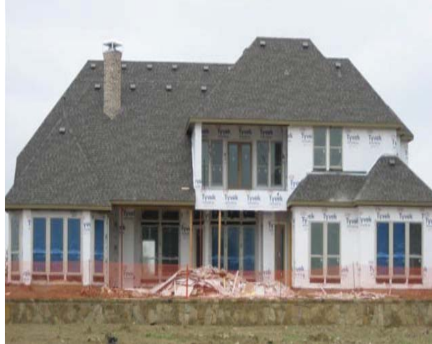
Fig. No. 22. Techumbre terminada, vease la chimenea y los diferentes respiraderos.
