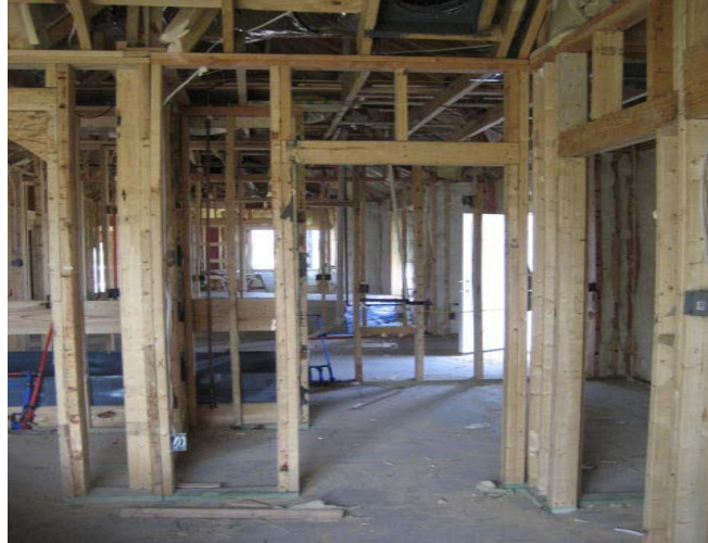
Fig. No. 17. Armado de cerramientos para puertas.
