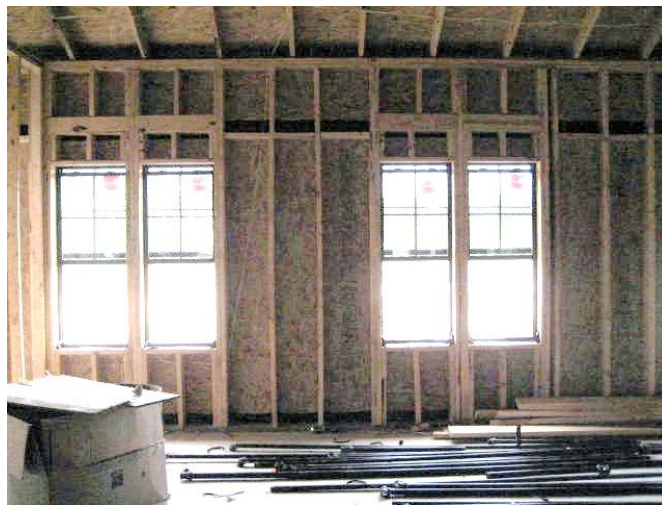
Fig. No. 18. Cerramientos de ventanas.
