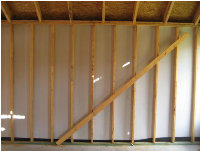
Fig.No. 15. Vista de la estructura de un muro y su techumbre.
