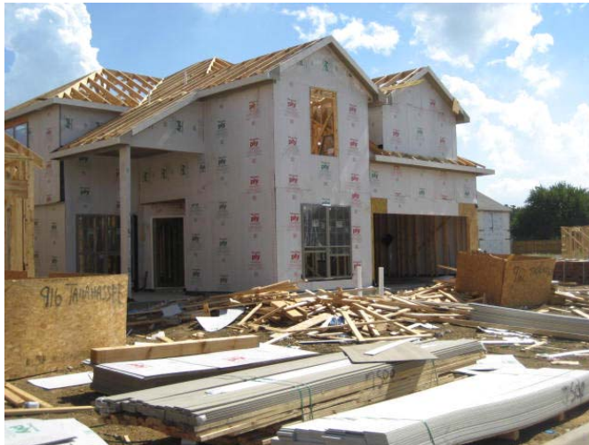
Fig. No. 7. Nótese la capa de poliuretano en color blanco que cubre las paredes exteriores.
