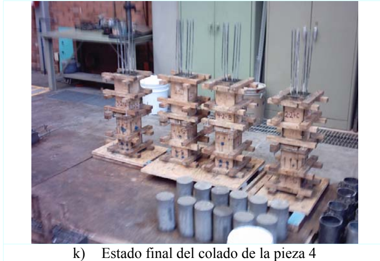
Fig. 3.26. Aspectos del proceso constructivo del espécimen (continuación)
