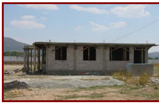
Construcciones en zona B
