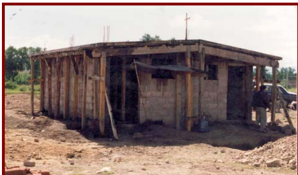
Obras constructivas en Zona B de nntferción
