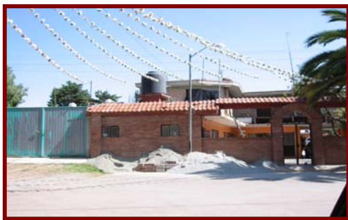
Construcciones en zona C, del Decreto Presidencial
