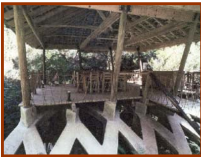
Áreas de descanso para visitantes a la ZAT, sin afectación del subsuelo
