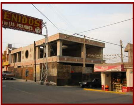
Falta de aplicación de la normatividad del 1988
