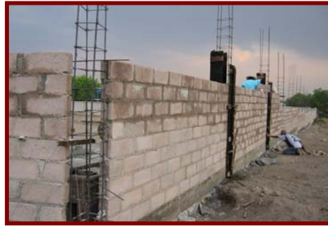
Obra en proceso de
