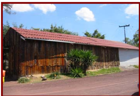
Construcción de nuevos restaurantes en zonas restringidas por el Decreto de 1988
