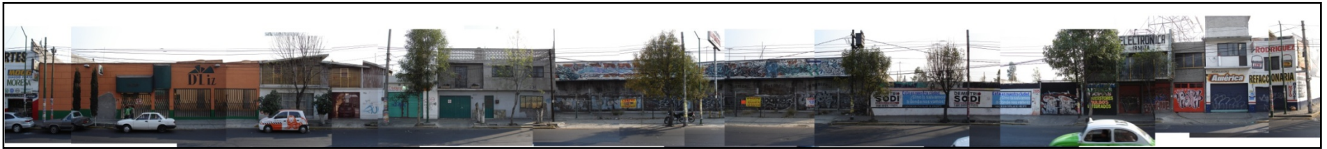
Perfil de la Avenida Ermita Iztapalapa y el predio.
