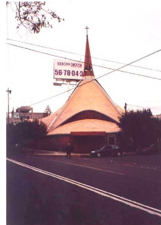
Fachada principal, lateral de periférico sur.
