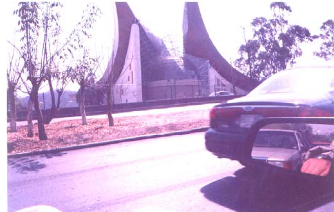
Vista domo, principal, ubicado sobre el Altar del templo ilumina con su luz solar el santuario y el campo santo, localizado este último en el sótano y posterior al Altar.
