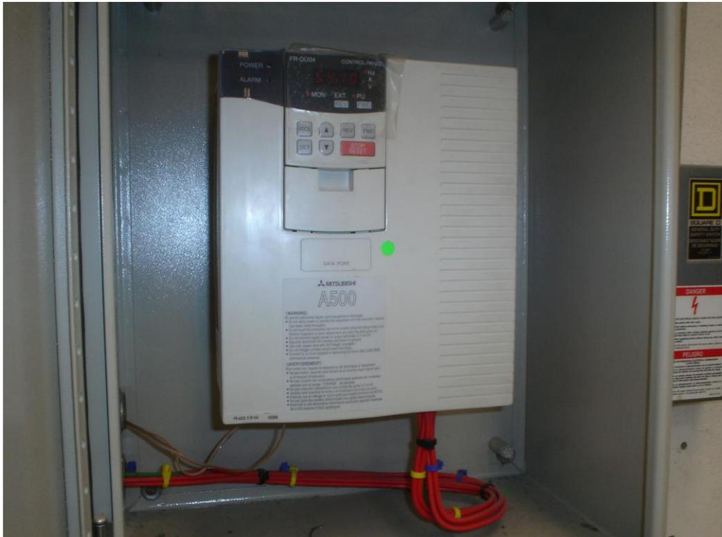
Fig. 2.4 Inversor de frecuencia
