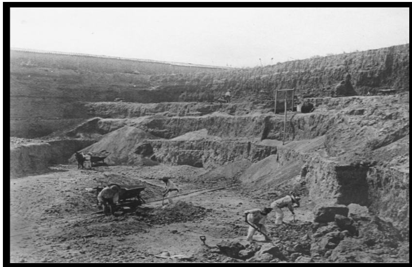
17AVI10. Ignacio Avilez, “Ladrilleras y minas de arena en Mixcoac”, 1920. Extracción de tierra y arena para la elaboración de ladrillos en La Moderna.
