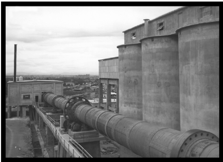
19EDI10. Díaz, Delgado y García, “Cementera La Tolteca”, 1931. Toma de las instalaciones hacia el oriente. Al fondo se aprecia la colonia San Pedro de los Pinos.
