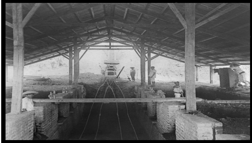
17AVI11. Ignacio Avilez, “Ladrilleras y minas de arena en Mixcoac”, 1920. Los pudrideros en La Moderna.
