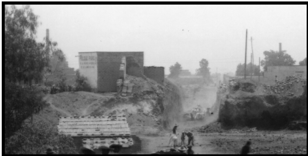
17SCO62. Ignacio Avilez-SCOP, “Construcción de la Avenida de los Insurgentes”, 1921-1924. Detalle. En los extremos laterales de la imagen se alcanzan a ver dos chimeneas.
