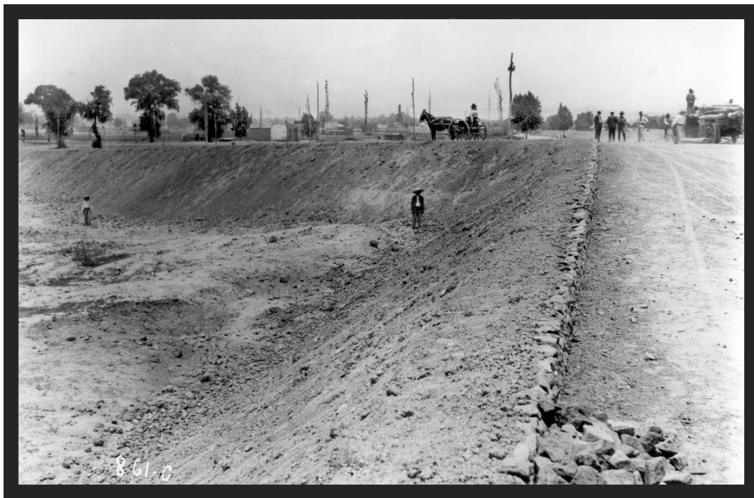
17SCO68. Ignacio Avilez-SCOP, “Construcción de la Avenida de los Insurgentes”, 1921-1924. Probable tramo a la altura de la glorieta de la calzada de Actipan y la colonia Del Valle.
