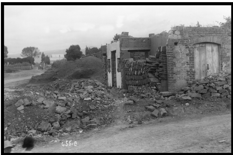
17SCO47. Ignacio Avilez-SCOP, “Construcción de la Avenida de los Insurgentes”, 1921-1924. Casa afectada por la obra registrada para realizar obras de reconstrucción.
