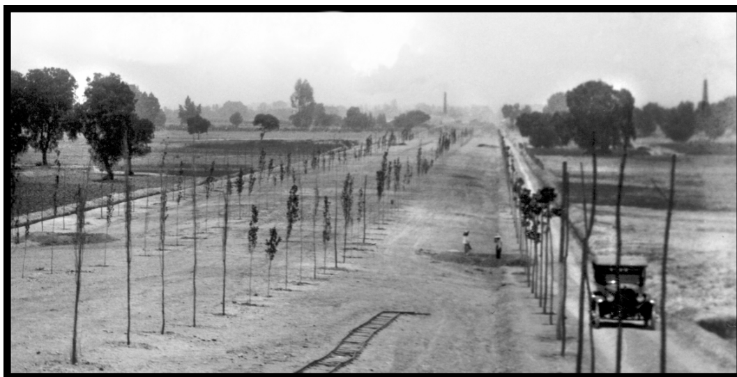
17SCO53. Ignacio Avilez-SCOP, “Construcción de la Avenida de los Insurgentes”, 1921-1924. Detalle. Al fondo se asoman las chimeneas de las ladrilleras.
