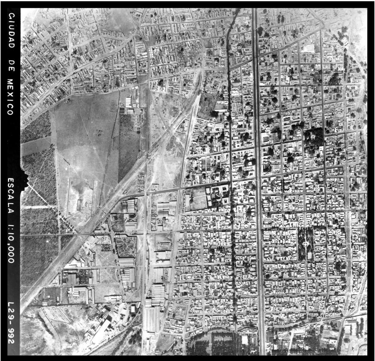
14AER33. Compañía Mexicana de Aerofoto, L29-992 , 1945. Toma aérea de la colonia San Pedro de los Pinos y de las Lomas de Becerra con La Tolteca en la parte inferior izquierda.
